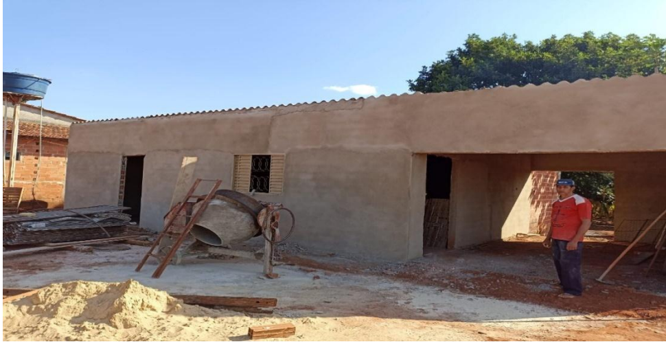
Figura 19 – Construção da farinha (área externa)
