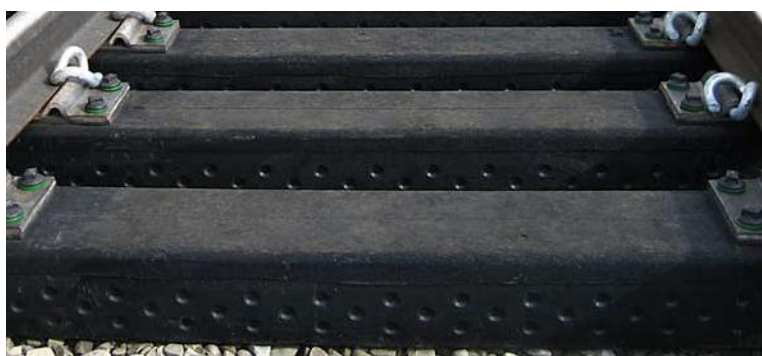
Figura 3.4 - Dormentes de Material Compósito
