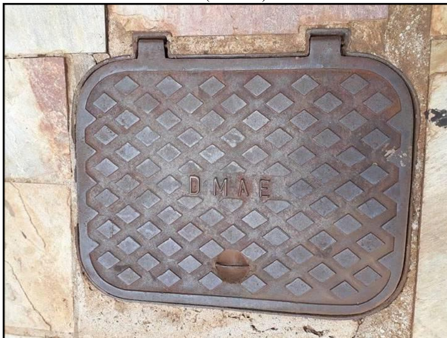
Foto 2 - Caixa de decantação padrão em Uberlândia (MG), local de coleta de amostras de efluentes (Fechada)
