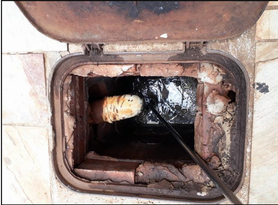
Foto 3 - Caixa de decantação padrão em Uberlândia (MG) e local de coleta de amostras de efluentes (Aberta)
