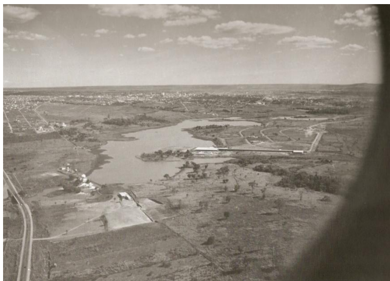
Foto 01 – Usina do Jaó, 1957
