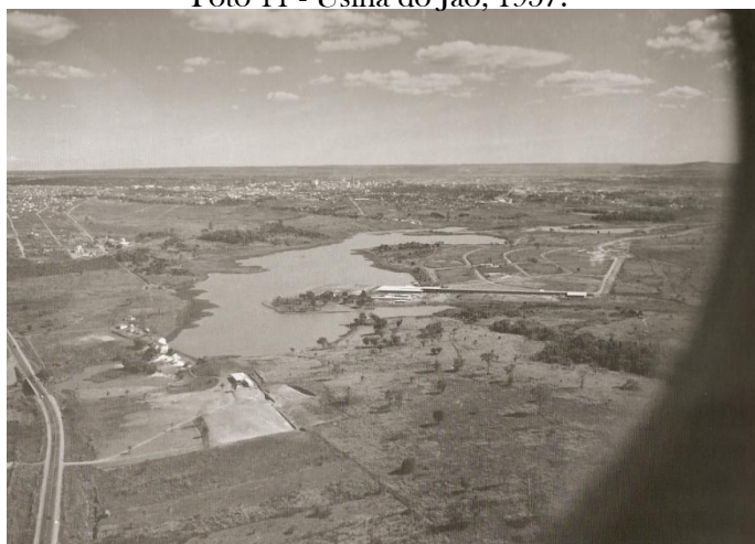
Foto 11 - Usina do Jaó, 1957.
