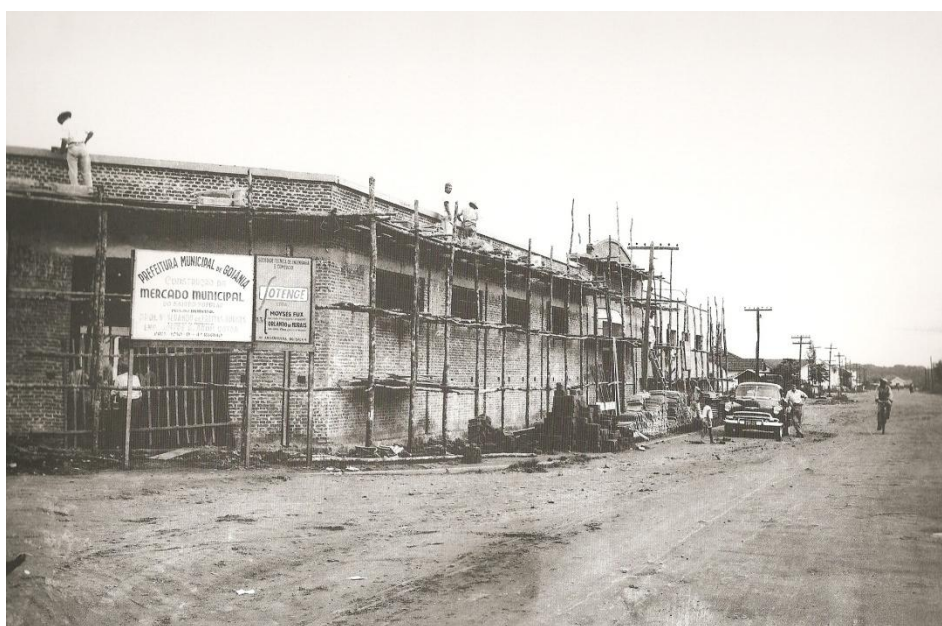
Foto 07- Trabalhadores na Construção do Mercado Municipal, 1952
