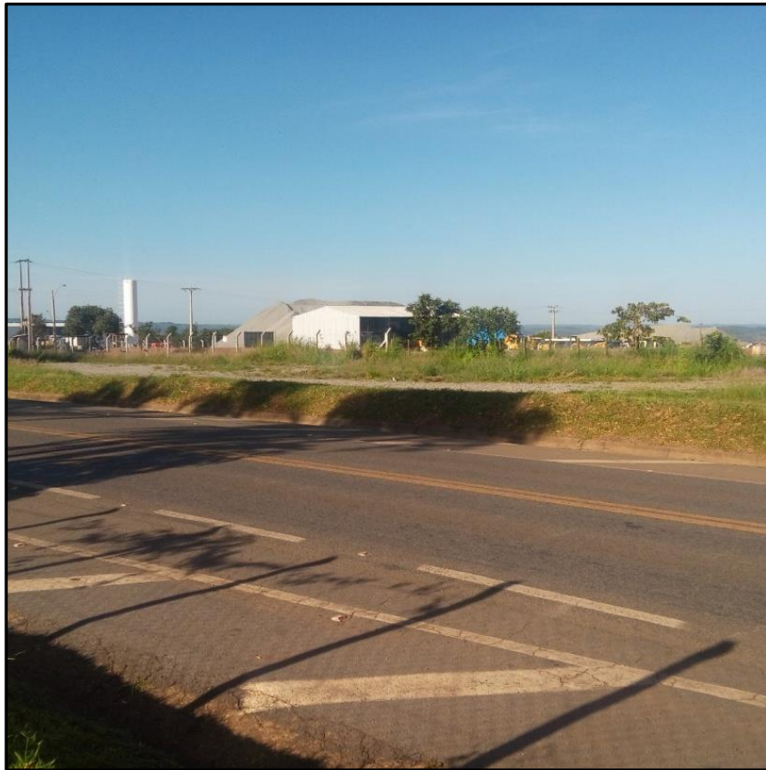
Foto 03: (Instalações da EGP – Empresa Global de Projeto – margem esquerda da BR 050 2019)
