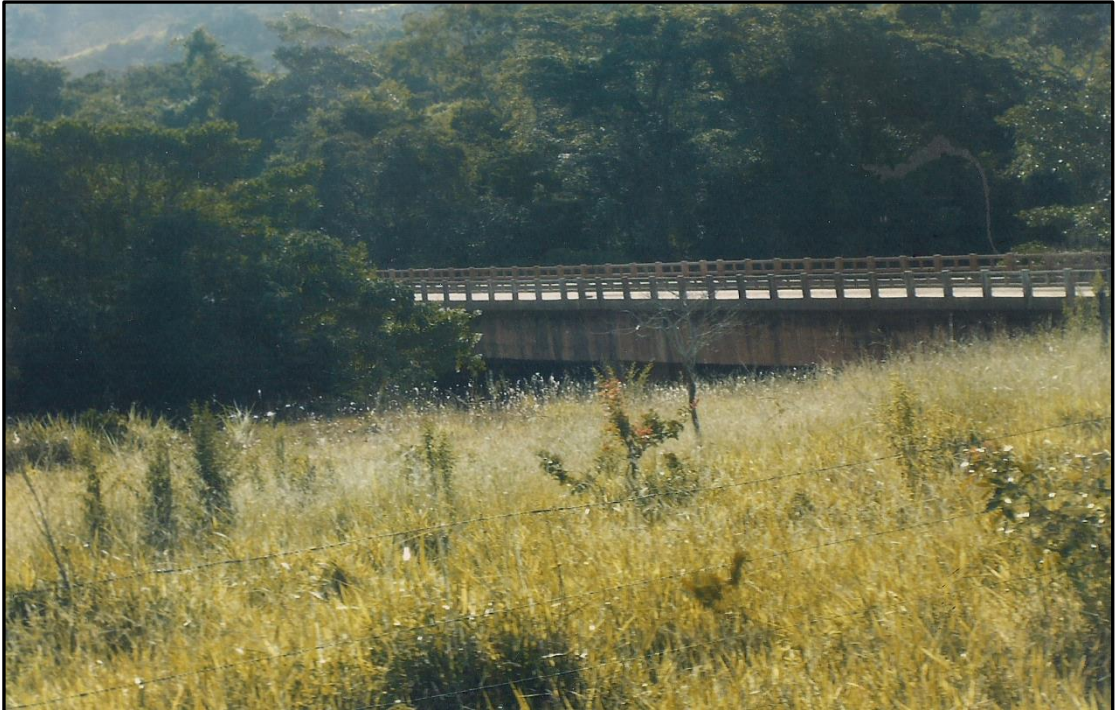
Foto 10: Ponte dos Carapinas – Pires Belo/Santo Antônio do Rio Verde (2009)
