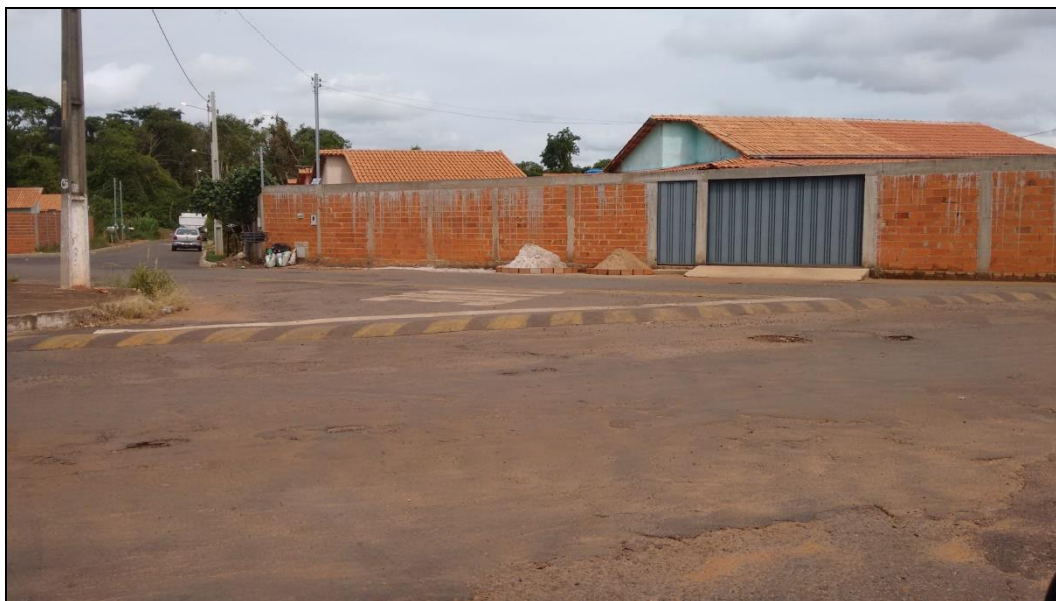
Foto 7 – Moradias de interesse social no Setor Monte Verde em Morrinhos (GO): infraestrutura asfáltica e intervenção urbanística
