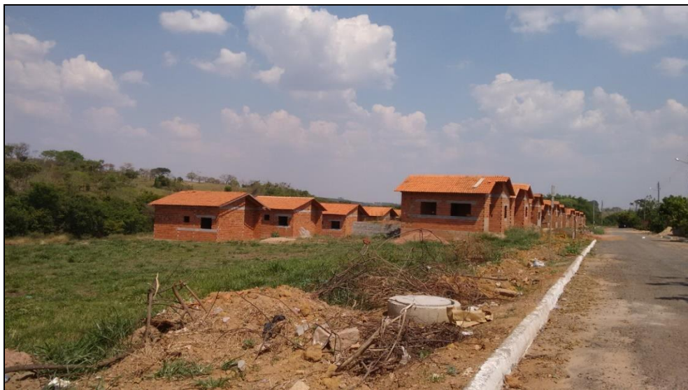
Foto 1 – Morrinhos (GO), setor Vila Nova III: construção de HIS, 2015
