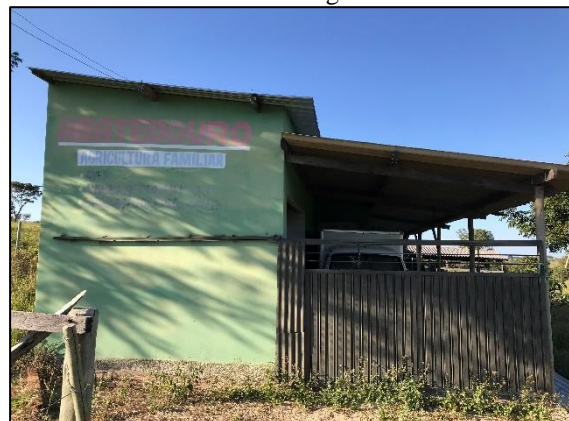
Foto 46 – Abatedouro de frangos.
