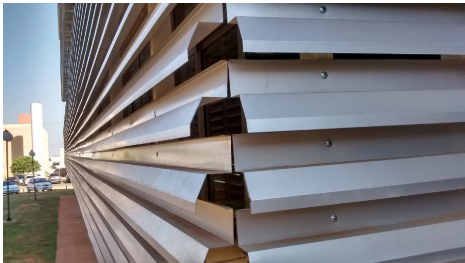
Figura 6 - Brise-soleil horizontal fixo do Prédio Multifuncional, UFG-RC.
