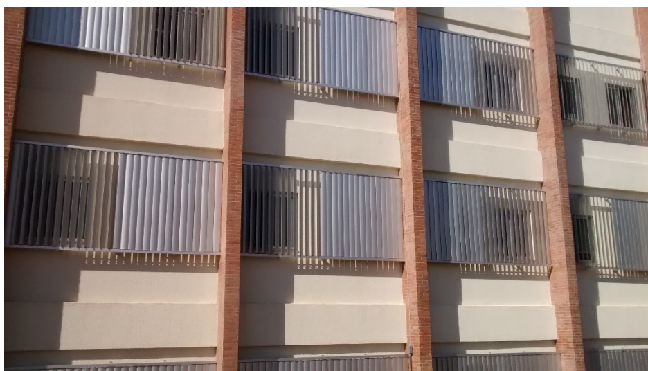
Figura 8 – Brise-soleil vertical flexível, Edifício das Engenharias, UFG-RC.
