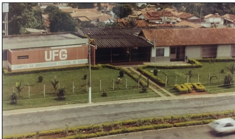
Figura 2 - Vista aérea da entrada principal do Campus da Regional Catalão
