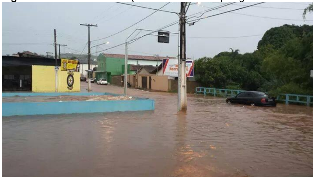
Figura 11 - Final da canalização do Ribeirão Pirapitinga
