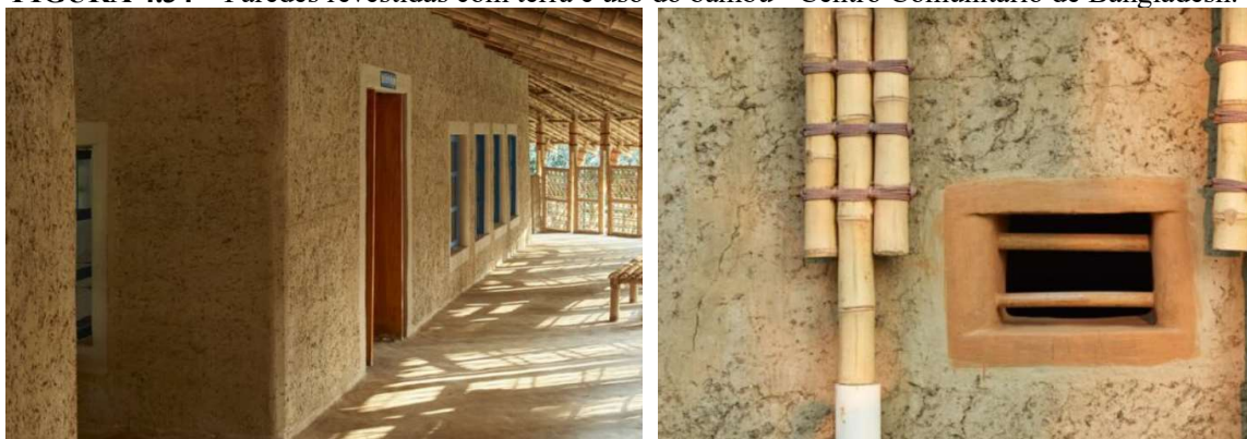
FIGURA 4.34 – Paredes revestidas com terra e uso do bambu - Centro Comunitário de Bangladesh.
