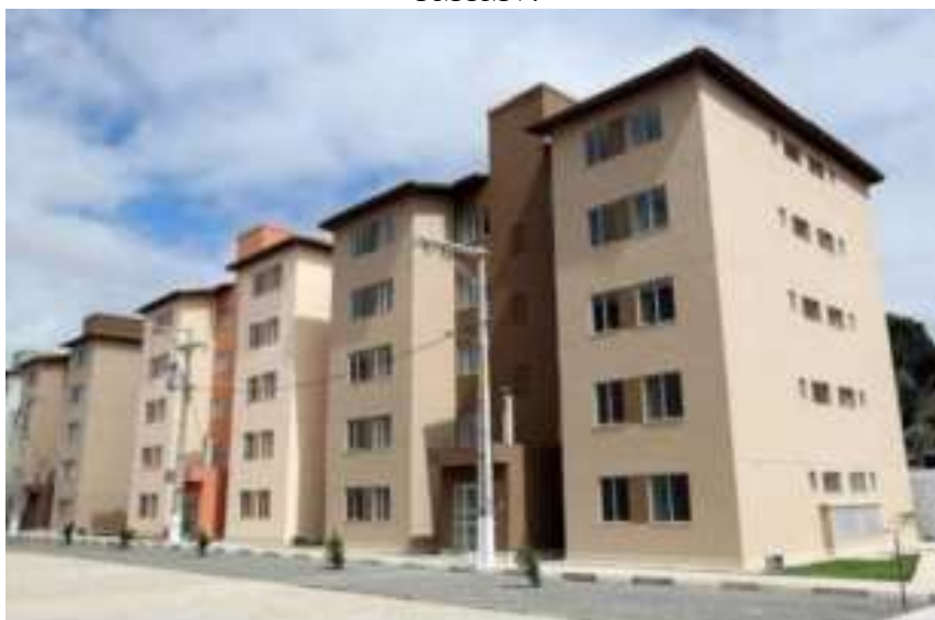
FIGURA 3.8 – Unidades Habitacionais Verticais – Tipologia Conjunto de Apartamentos do PMCMV.
