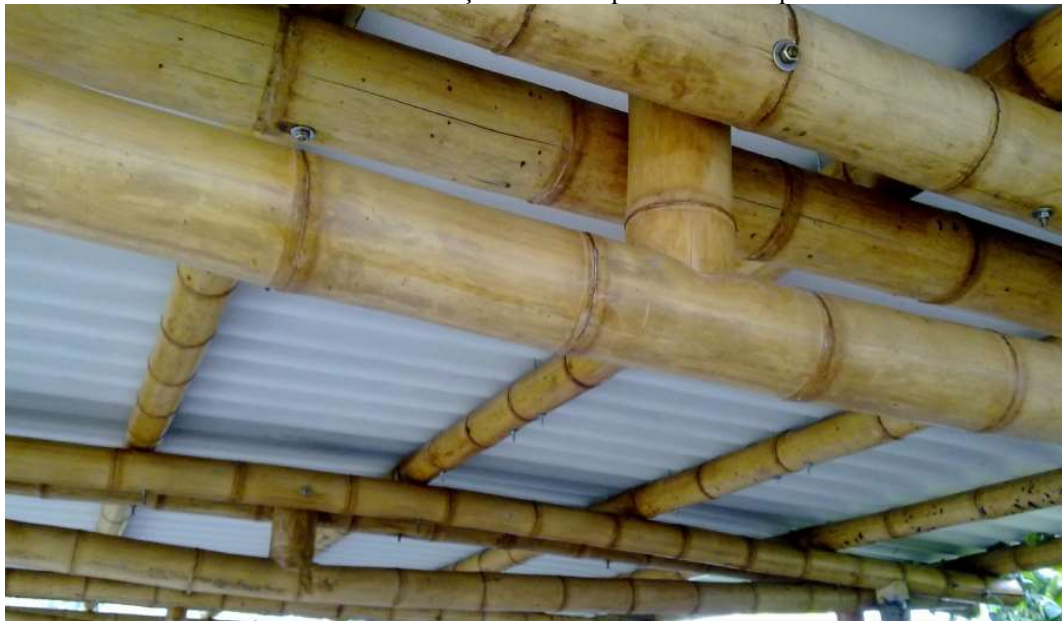
FIGURA 4.23 – Treliça de bambu para cobertura pesada.
