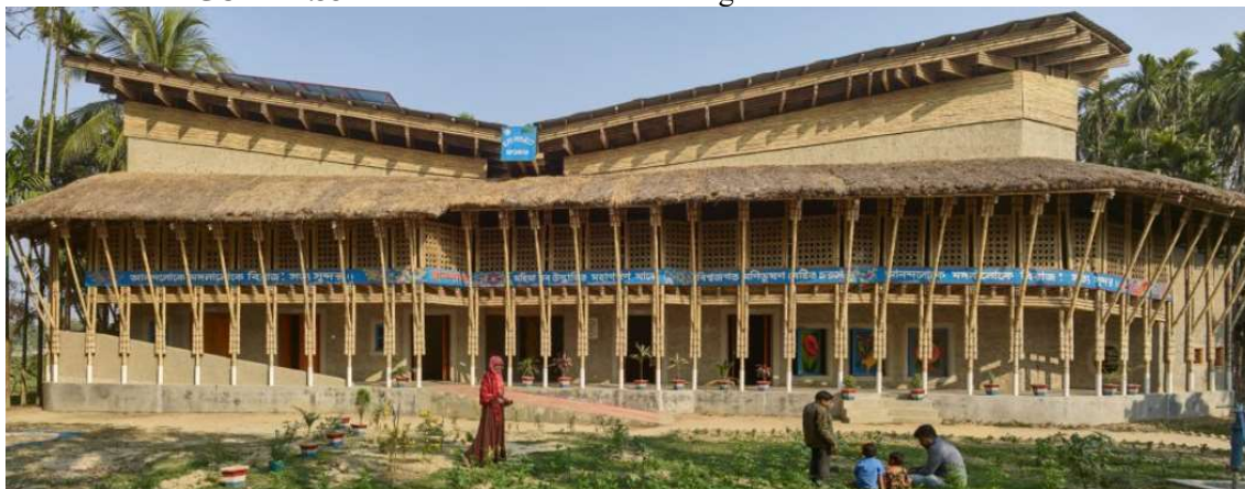
FIGURA 4.33 – Centro Comunitário de Bangladesh feito de bambu e terra.
