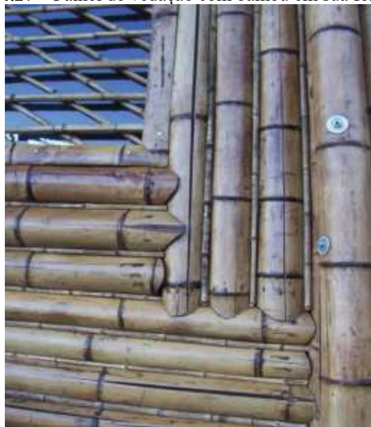
FIGURA 4.27 – Pannel de vedação com bambu em sua forma natural.
