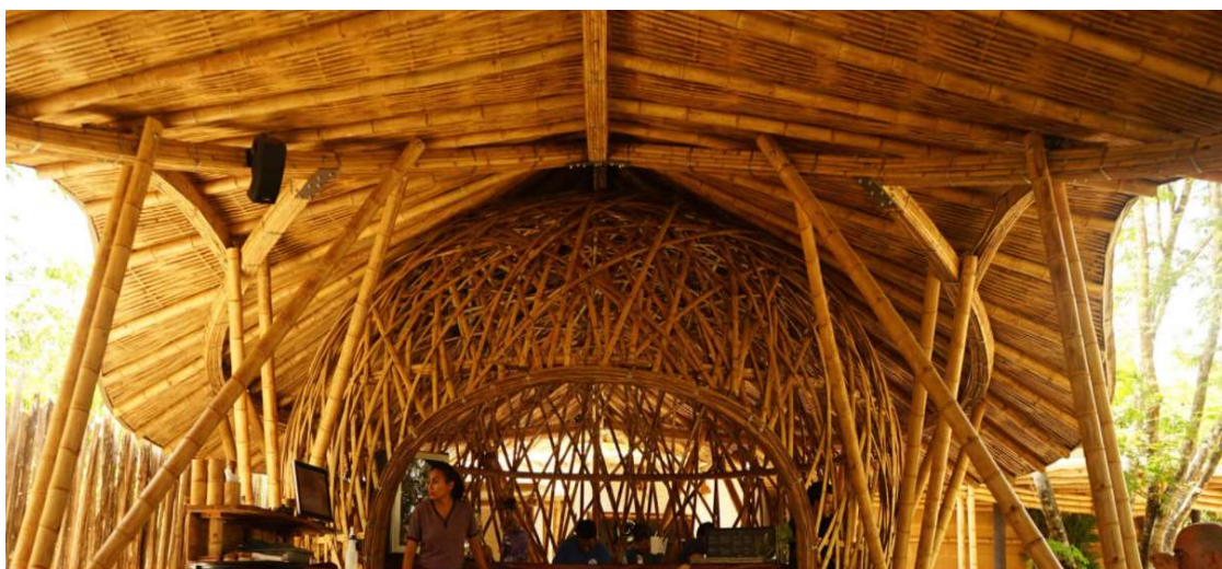
FIGURA 4.21 – Estruturas de telhado de bambu.
