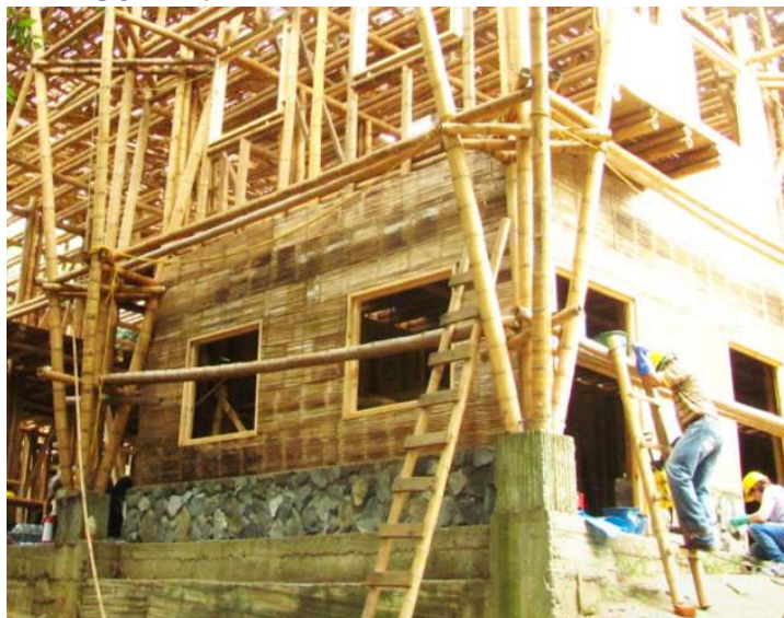
FIGURA 4.17 – Pilares com mix de bambu e concreto.
