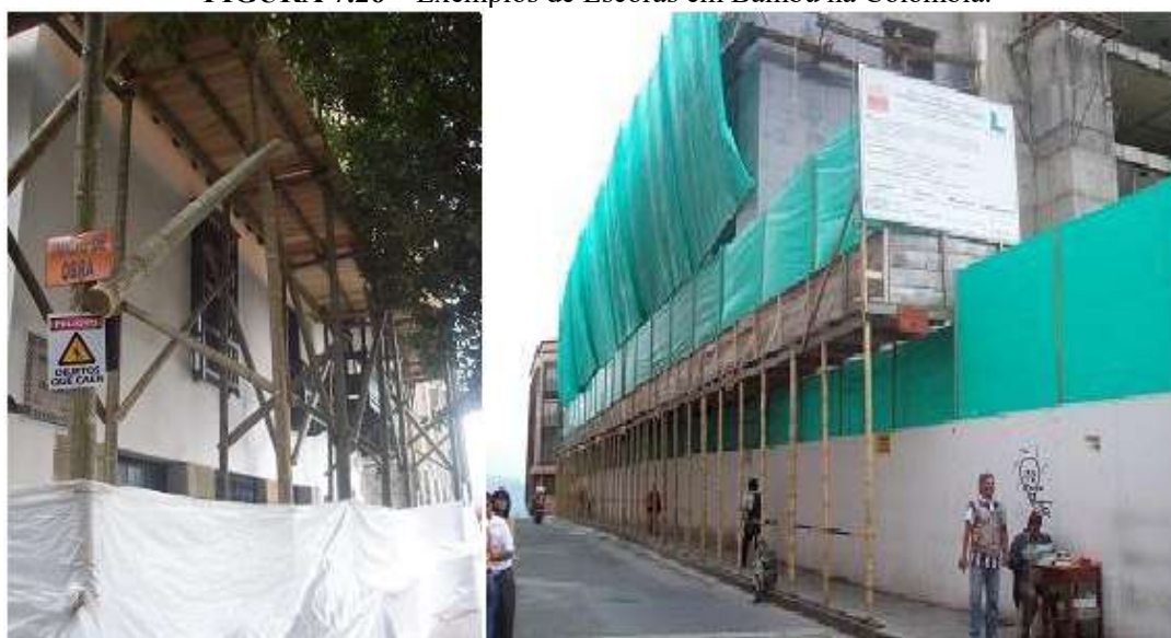
FIGURA 7.26 – Exemplos de Escoras em Bambu na Colômbia.
