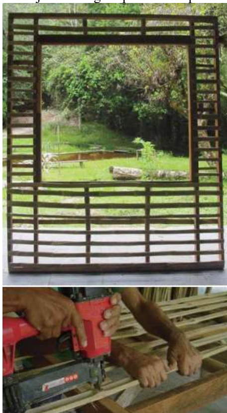
FIGURA 4.35 – Painel-janela e o grampeamento ripado de bambu no painel.
