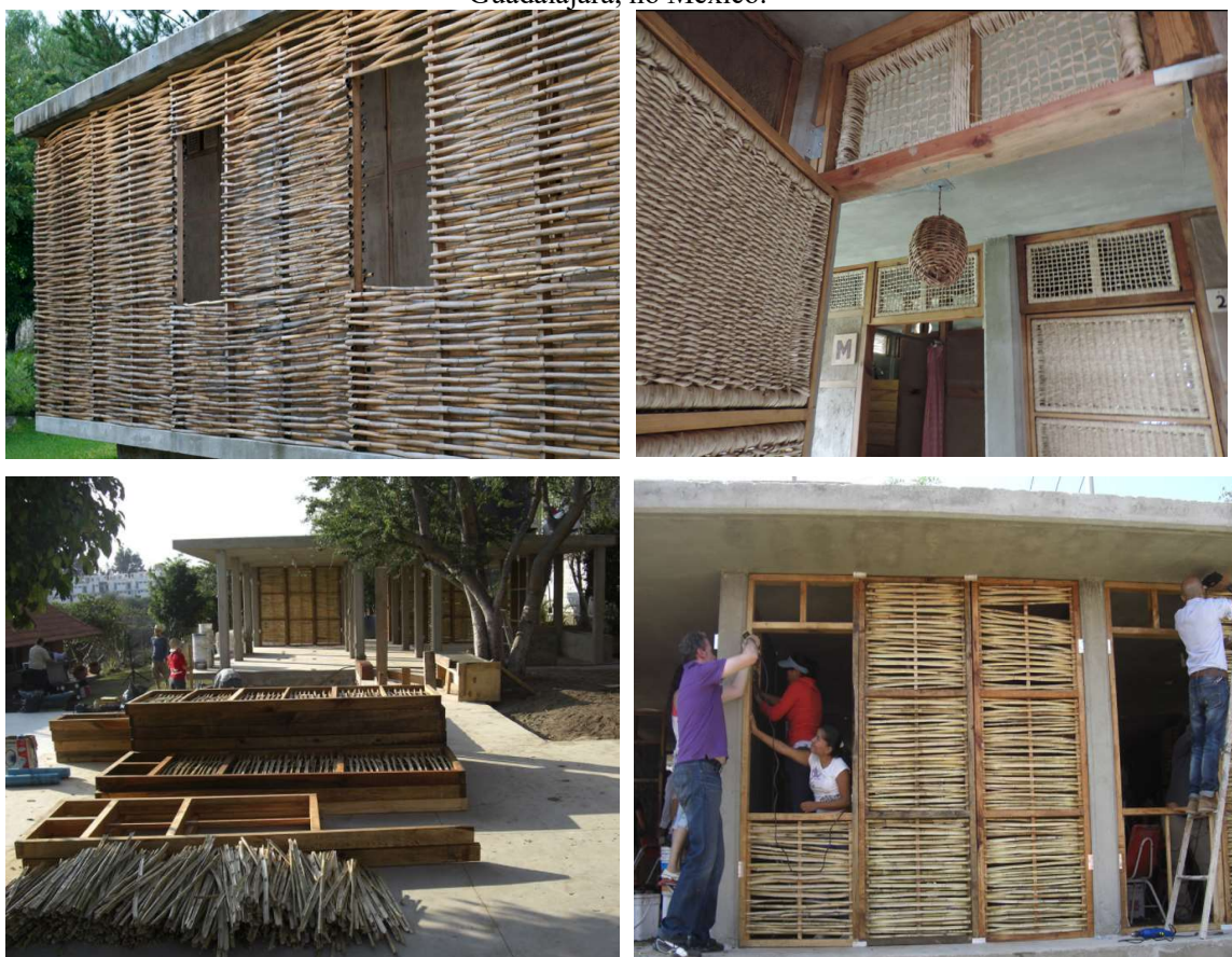
FIGURA 4.32 – Utilização do painel de vedação em bambu no Edifício Comunitário em Guadalajara, no México.
