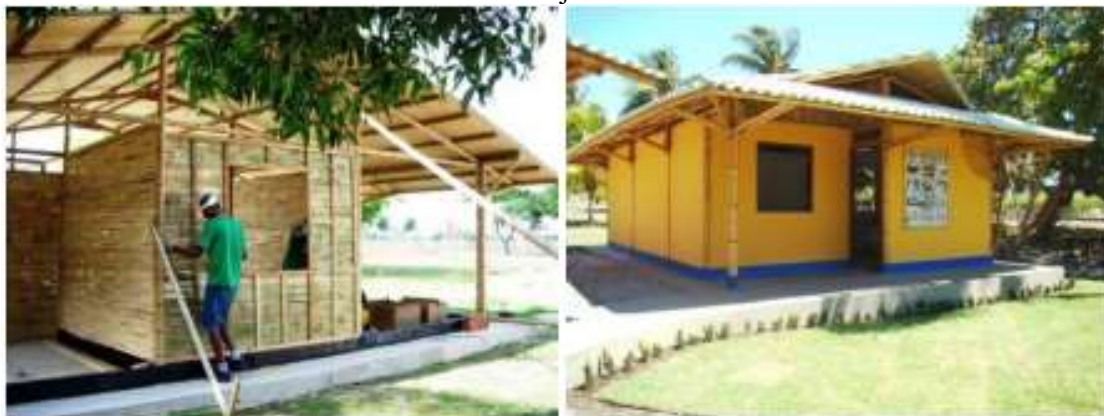
FIGURA 4.31 – Utilização do painel de vedação em bambu no Protótipo de Habitação Social em Aracaju/SE.
