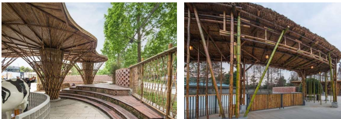
FIGURA 4.4 – Bamboo Garden – estrutura curva e base dos postes em concreto (2015).
