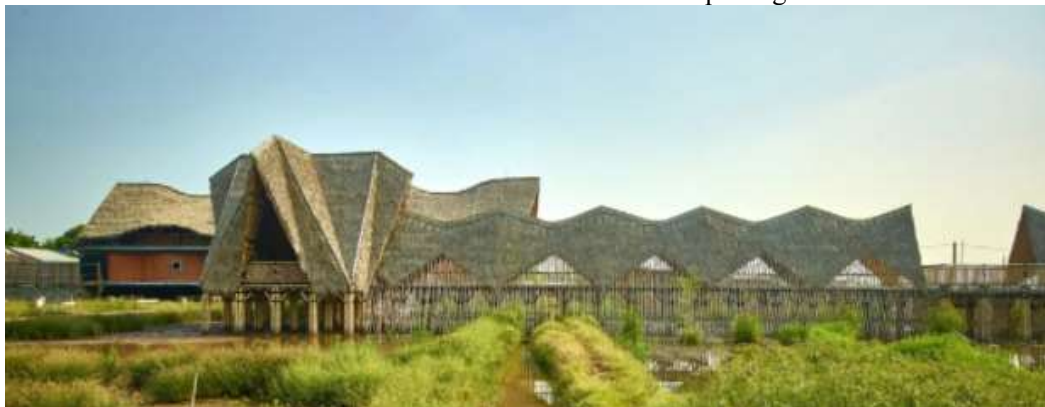
FIGURA 4.1 – Telhado de bambu em zigue-zague.
