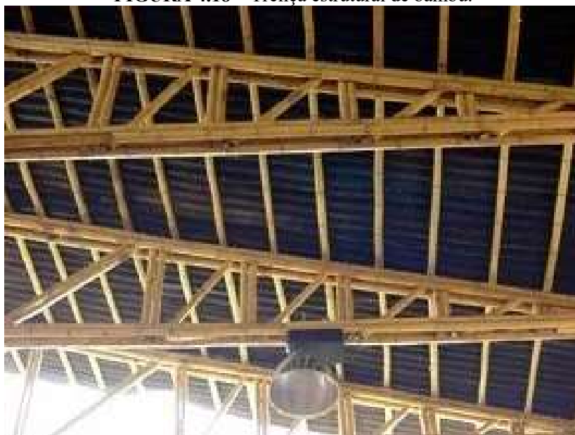
FIGURA 4.18 – Treliça estrutural de bambu.
