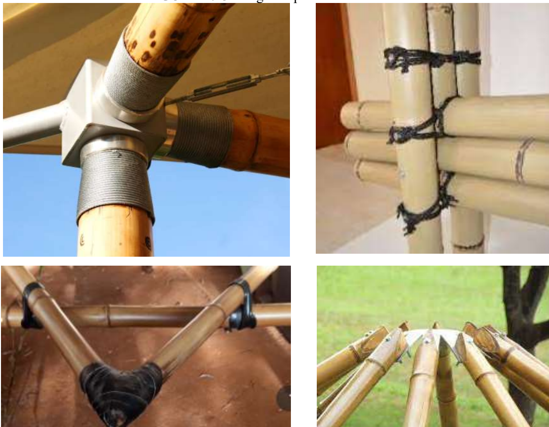
FIGURA 4.25 – Alguns tipos de nós e conexões.
