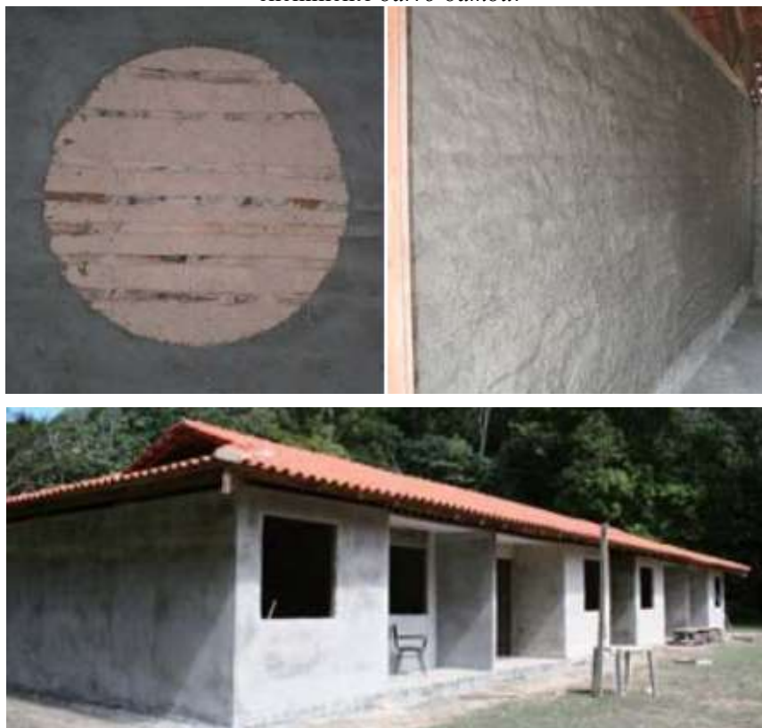
FIGURA 4.37 – Paineis chapiscado e rebocado com argamassa de cimento após a cura do enchimento barro-bambu .
