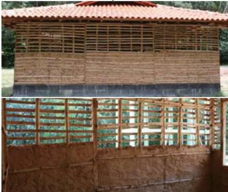
FIGURA 4.36 – Enchimento dos painéis de bambu com barro-bambu .
