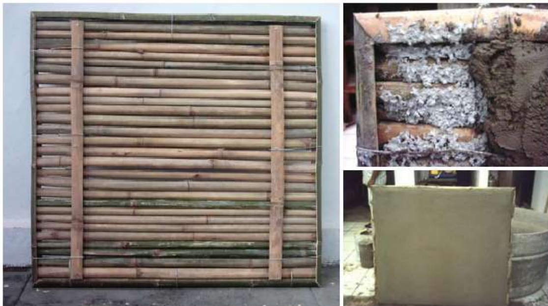
FIGURA 7.28 – Algumas Etapas de Execução dos Painéis de Vedação de Bambu.
