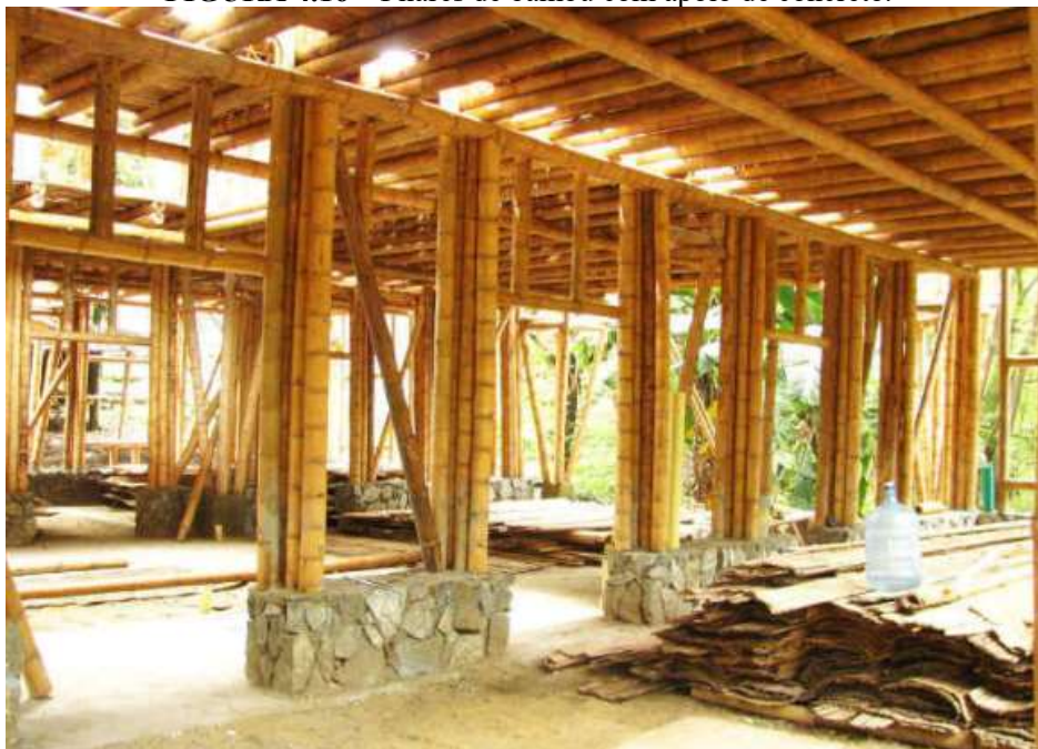
FIGURA 4.16 – Pilares de bambu com apoio de concreto.
