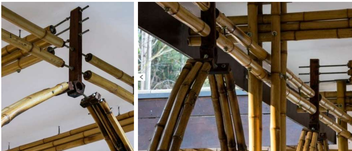
FIGURA 4.26 – Conexões das peças de bambu através do parafusamento.
