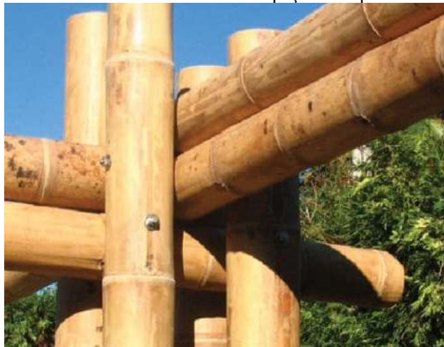
FIGURA 4.12 – Encaixes entre peças com parafusos.
