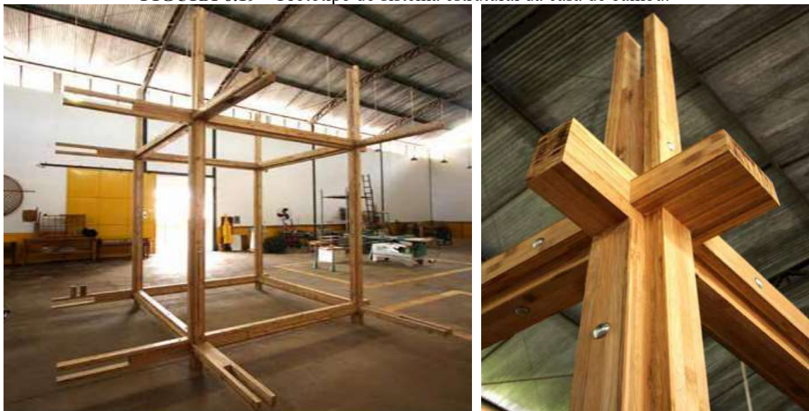
FIGURA 6.19 – Protótipo do sistema estrutural da casa de bambu.
