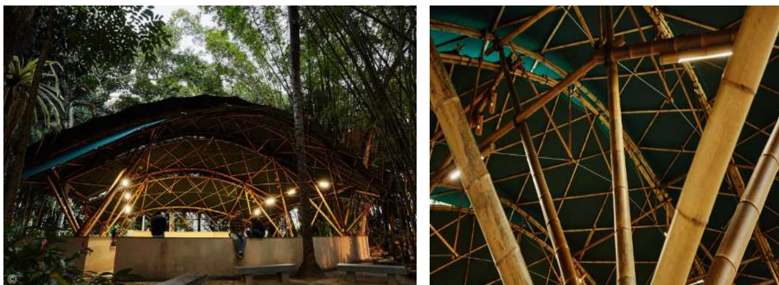
FIGURA 4.24 – Estrutura espacial de bambu.
