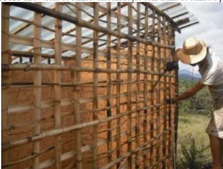
FIGURA 4.14 – Casa de bambu: bioconstrução com trama de bambu a pique.
