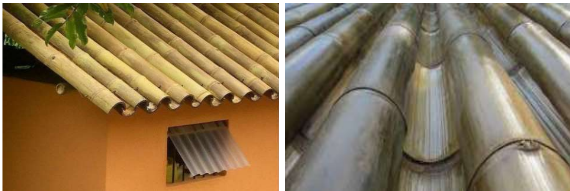
FIGURA 4.20 – Cobertura em telhas de bambu.
