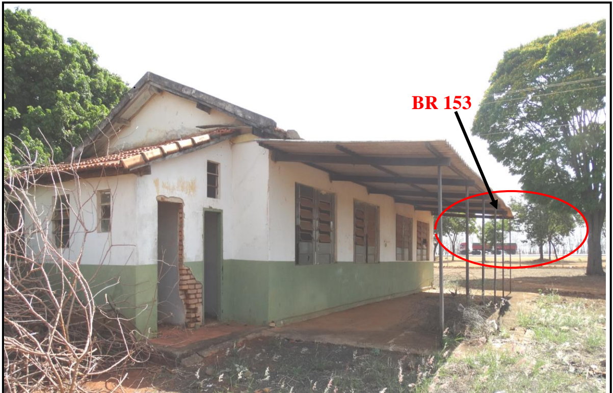
Foto 24 - Escola Samambaia às margens da BR-153 – Morrinhos/GO.
