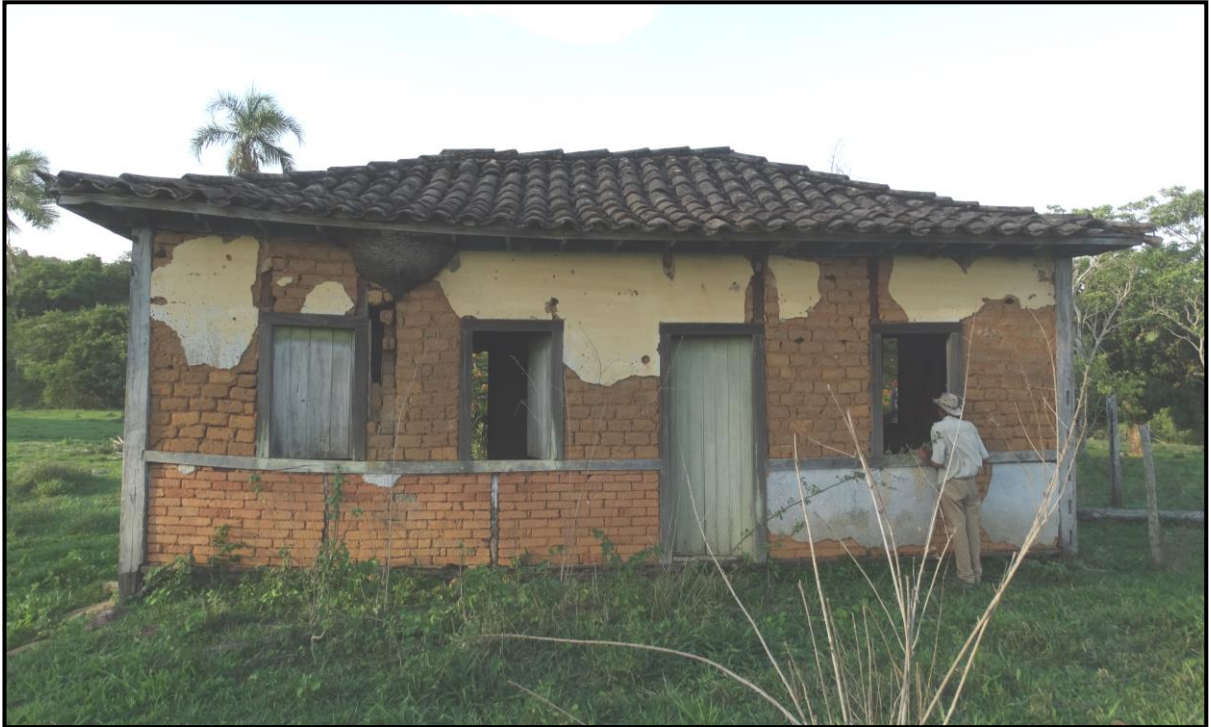
Foto 16 – Residência rural abandonada.
