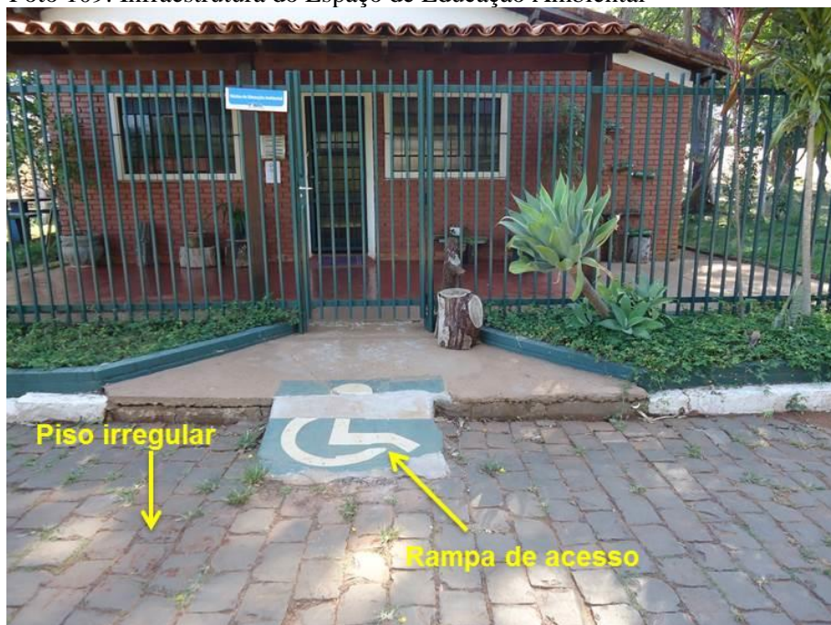
Foto 109: Infraestrutura do Espaço de Educação Ambiental
