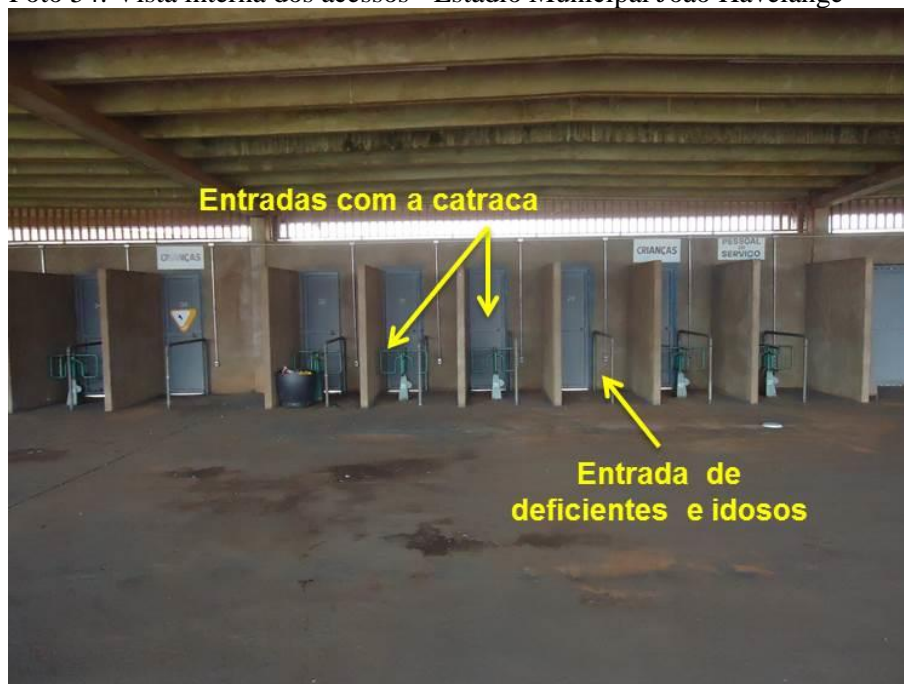
Foto 54: Vista interna dos acessos - Estádio Municipal João Havelange
