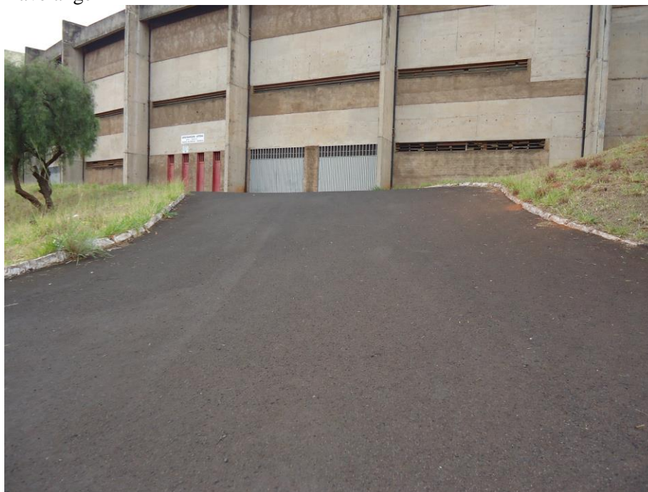
Foto 51: Acesso a bilheteria e portões de entrada do Estádio Municipal João Havelange
