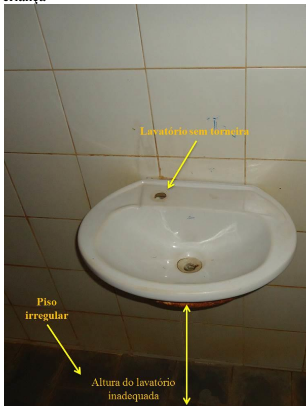
Foto 44: Infraestrutura do banheiro - Mundo da criança
