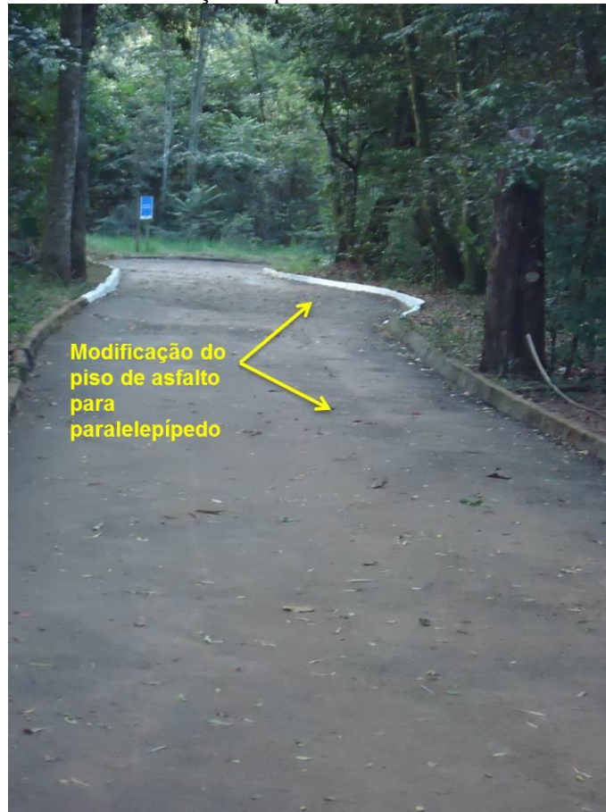
Foto 22: Modificação de piso – Portaria Santa Mônica
