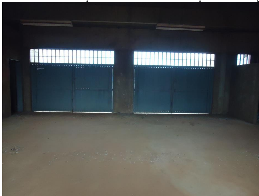
Foto 55: Vista interna dos portões de saída - Estádio Municipal João Havelange
