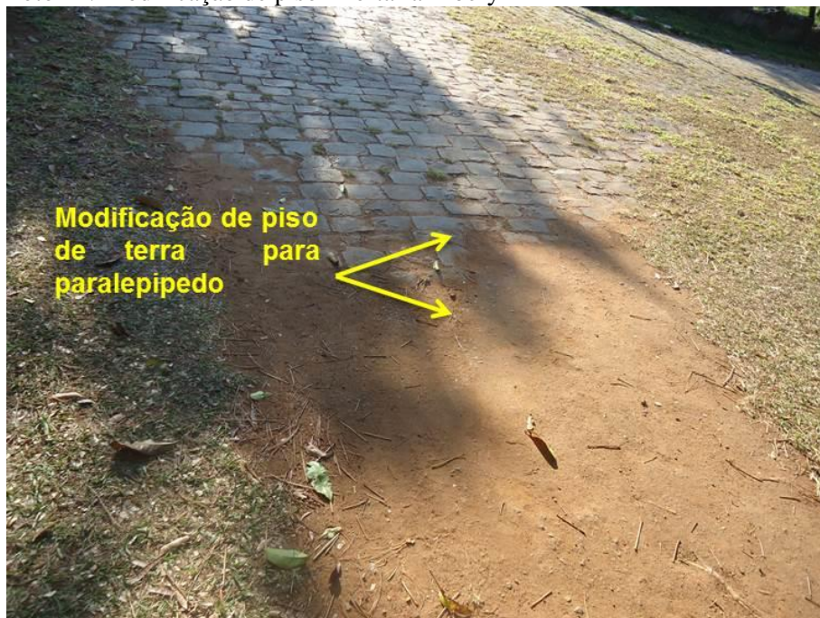
Foto 24: Modificação de piso– Portaria Tibery
