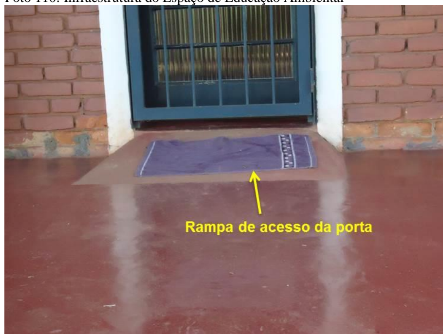
Foto 110: Infraestrutura do Espaço de Educação Ambiental
