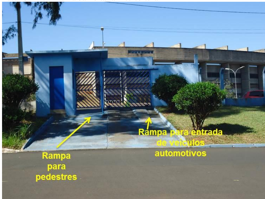
Foto 19: Área interna da Portaria Piscicultura
