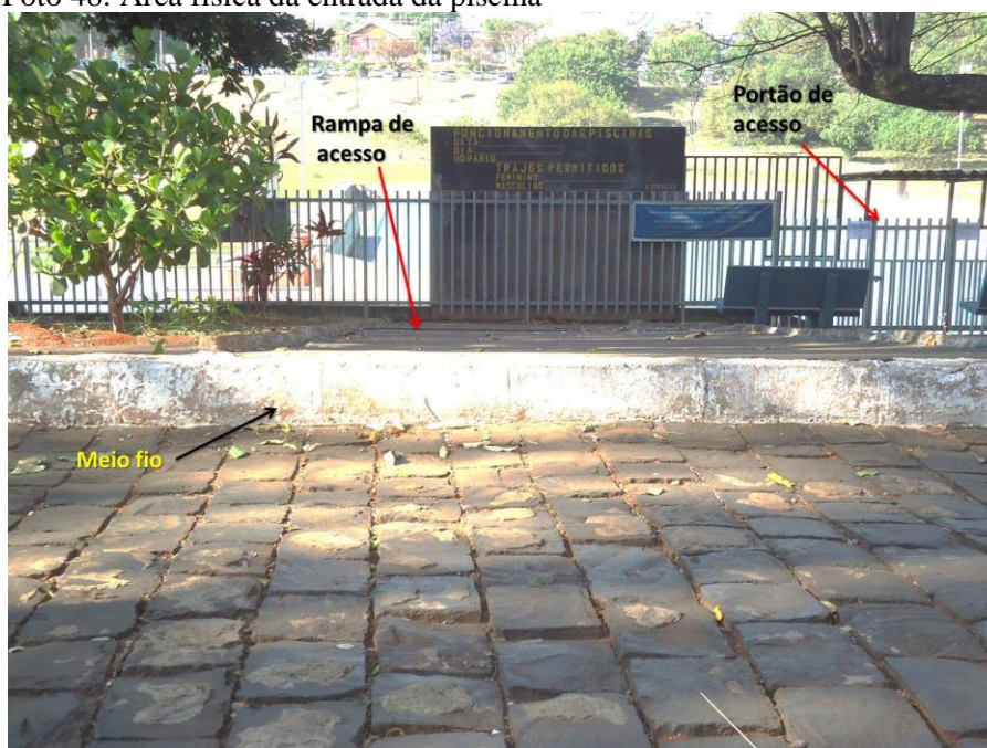
Foto 48: Área física da entrada da piscina
