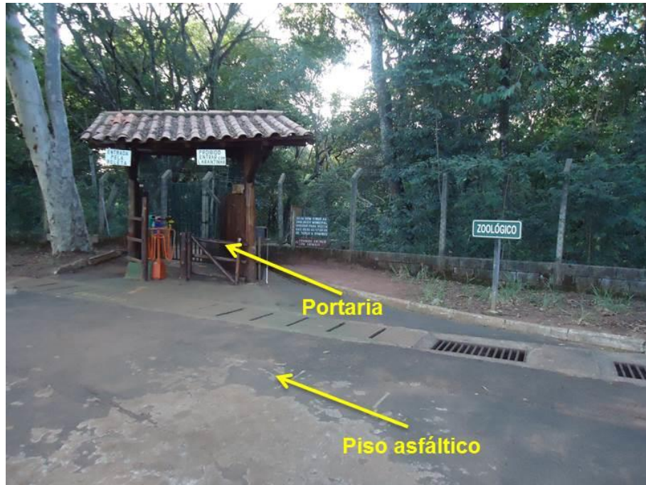
Foto 20: Piso asfáltico – Portaria Santa Mônica
