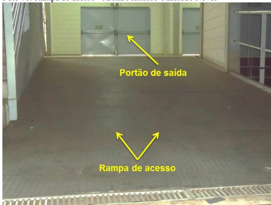
Foto 71: Rampa de acesso - Arena Multiuso Tancredo Neves
