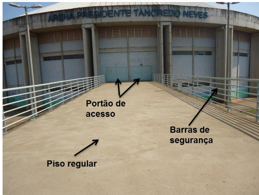
Foto 68: Portão de acesso da Arena Multiuso Tancredo Neves
