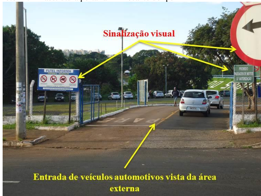
Foto 12: Infraestrutura portaria 2 – Recanto do Ipê
