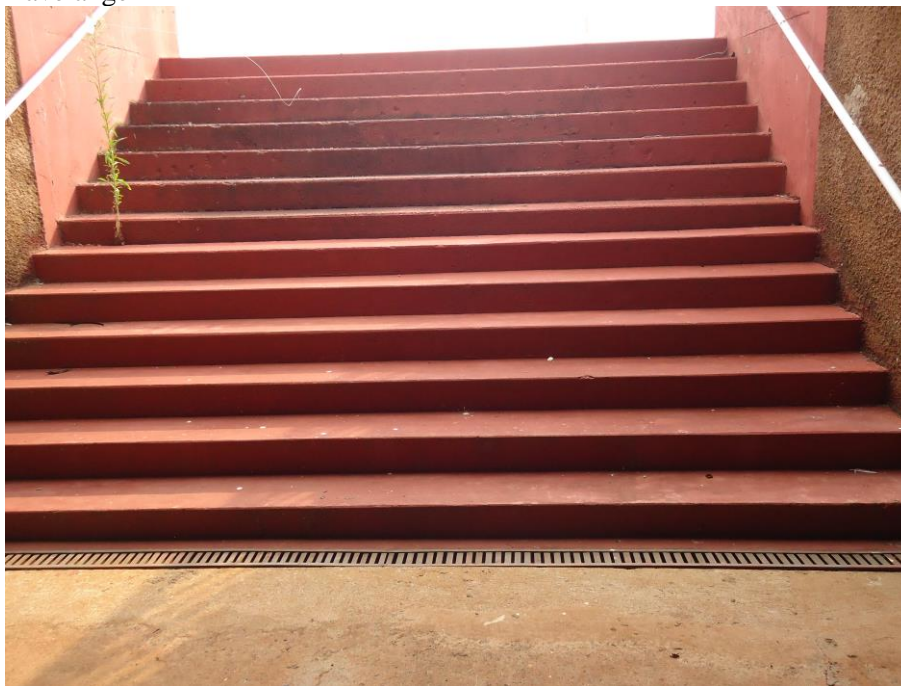
Foto 62: Escadas para acesso as arquibancadas - Estádio Municipal João Havelange
