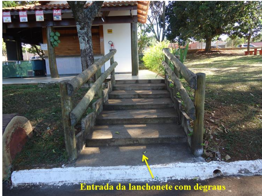
Foto 76: Parte da infraestrutura do Recanto do Sabiá
