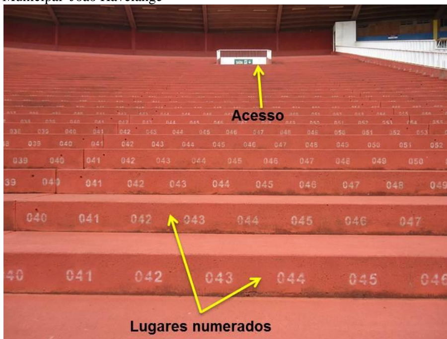
Foto 61: Infraestrutura das arquibancadas no cotovelo vermelho – Estádio Municipal João Havelange
