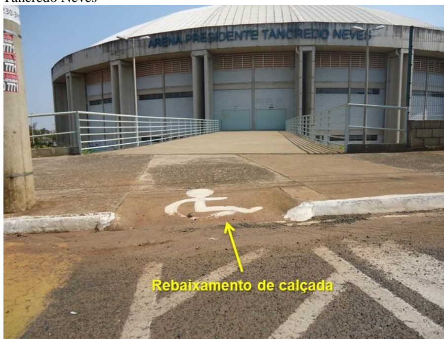
Foto 67: Rebaixamento de calçada na área externa Arena Multiuso Tancredo Neves
