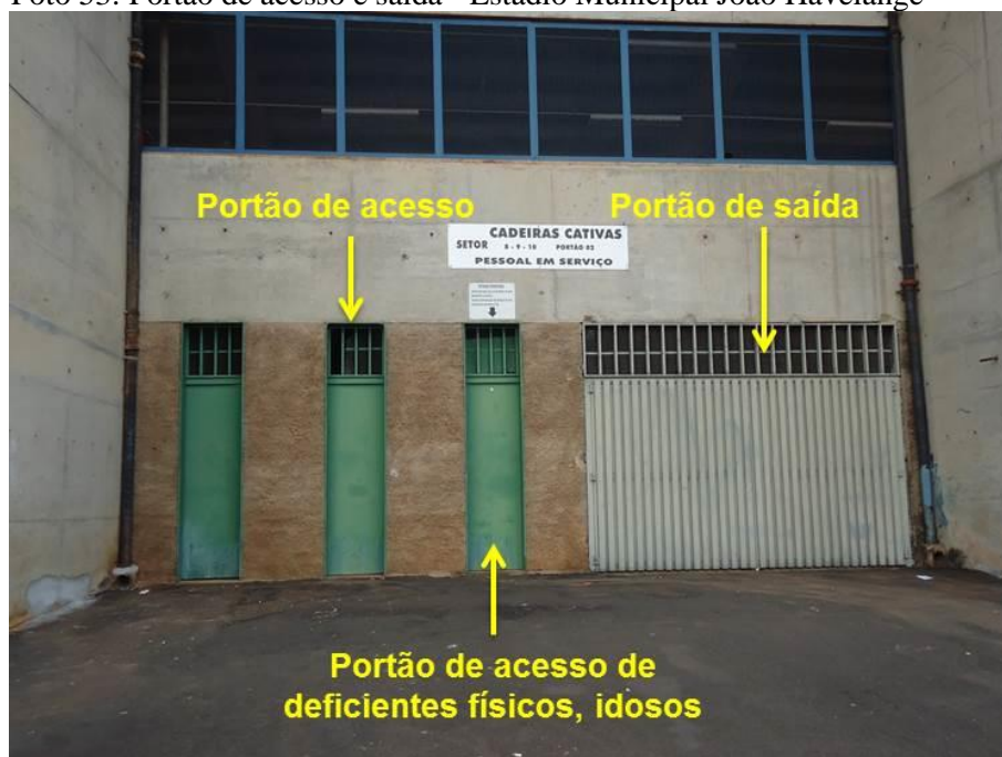
Foto 53: Portão de acesso e saída - Estádio Municipal João Havelange
