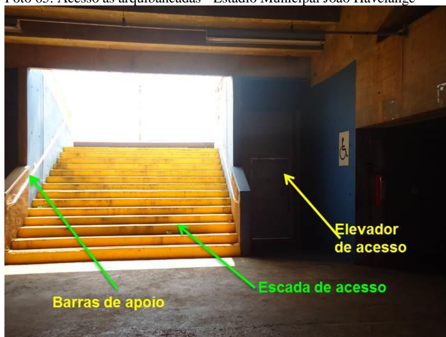
Foto 65: Acesso as arquibancadas - Estádio Municipal João Havelange
