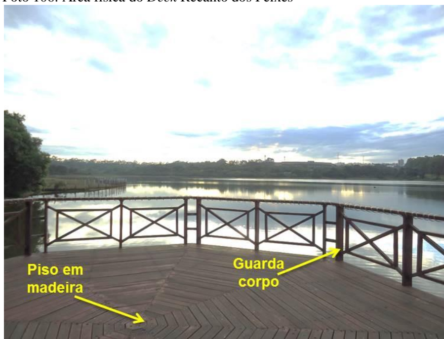
Foto 106: Área física do Deck Recanto dos Peixes
