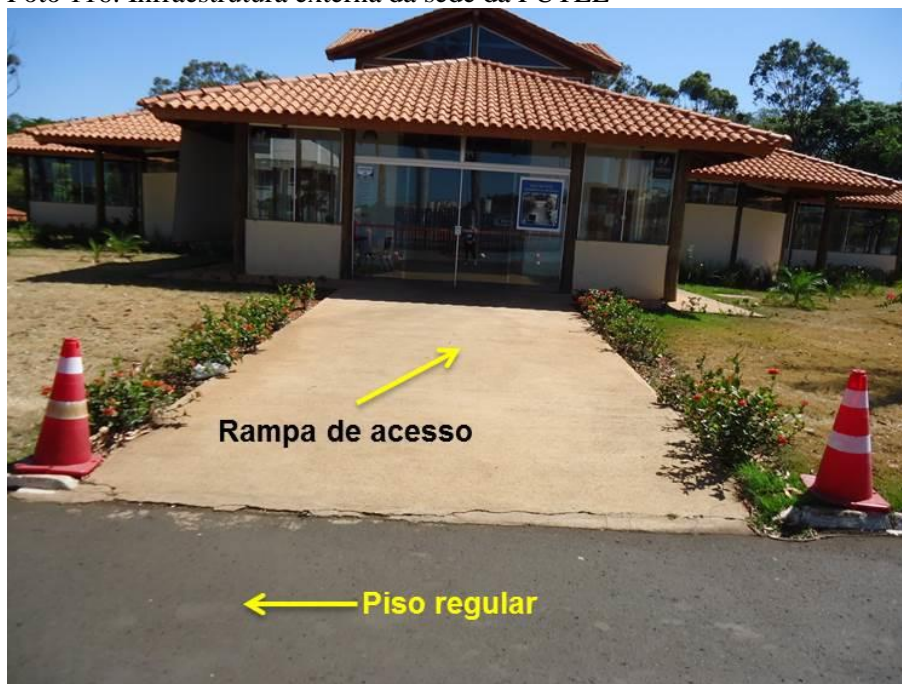
Foto 116: Infraestrutura externa da sede da FUTEL
