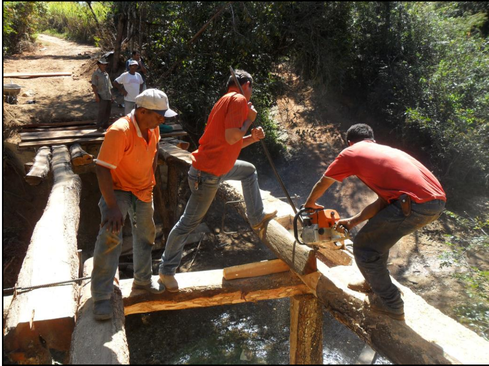
Foto 14: Mutirão para construção da segunda etapa da ponte no Assentamento Olga Benário FIRMINO, Waldivino Gomes (TRABALHO DE CAMPO, 2012).
