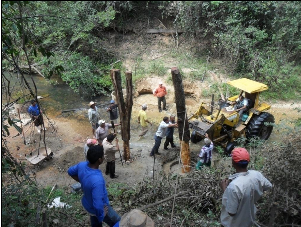
Foto 13: Mutirão para construção da primeira etapa de uma ponte no Assentamento Olga Benário FIRMINO, Waldivino Gomes (TRABALHO DE CAMPO, 2012).
