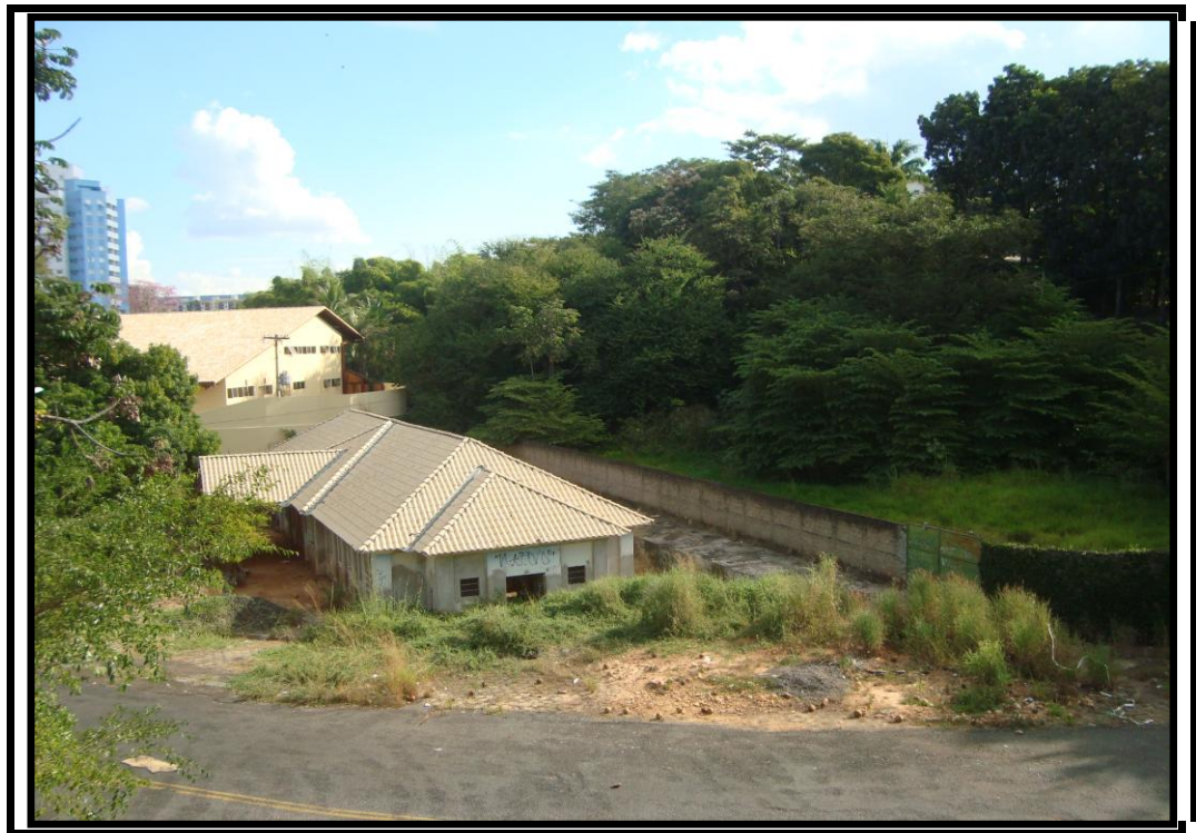
Figura 23: Balneário Municipal em situação de abandono.
