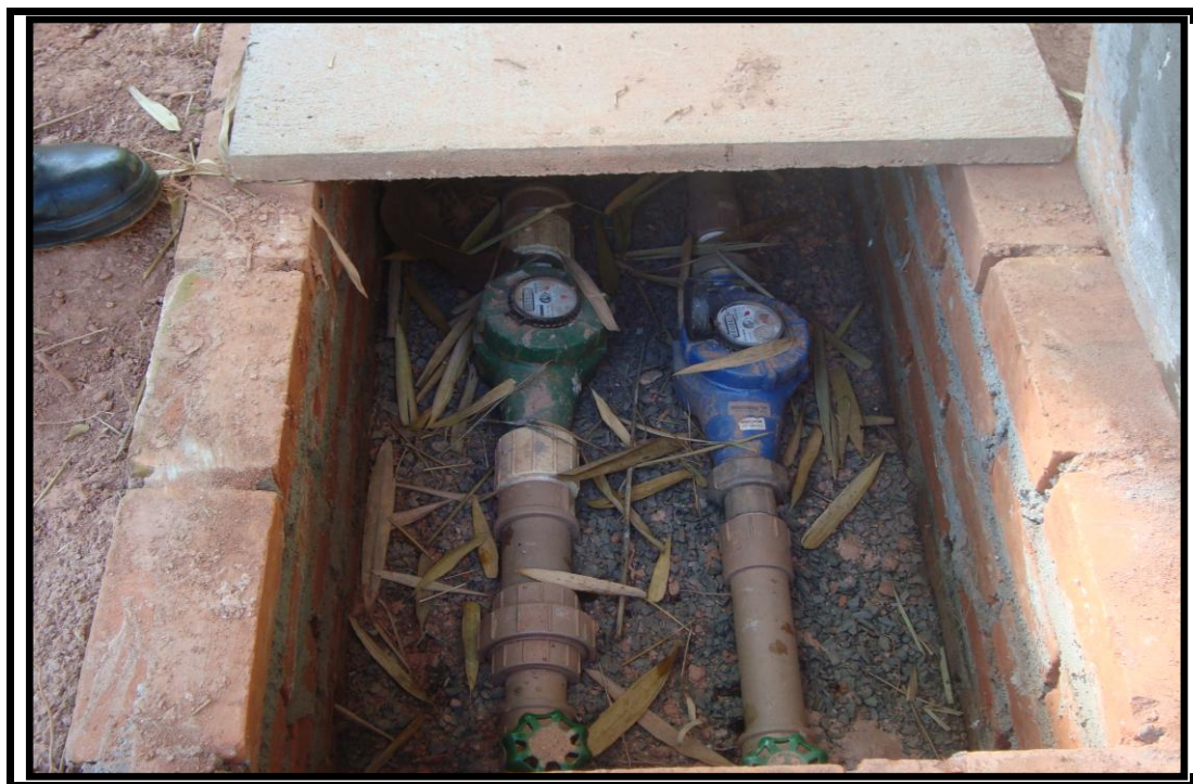
Figura 28: Hidrômetro para quantificar o volume efetivamente conduzido à infiltração. Foto: Suely Pereira de Sousa, 2009.
