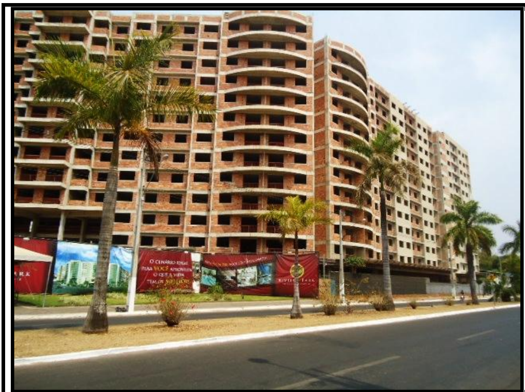
Figura 18: Obras de Condomínio residencial no Bairro Turista – Caldas Novas (GO) Foto: Suely Pereira de Sousa, 2010
