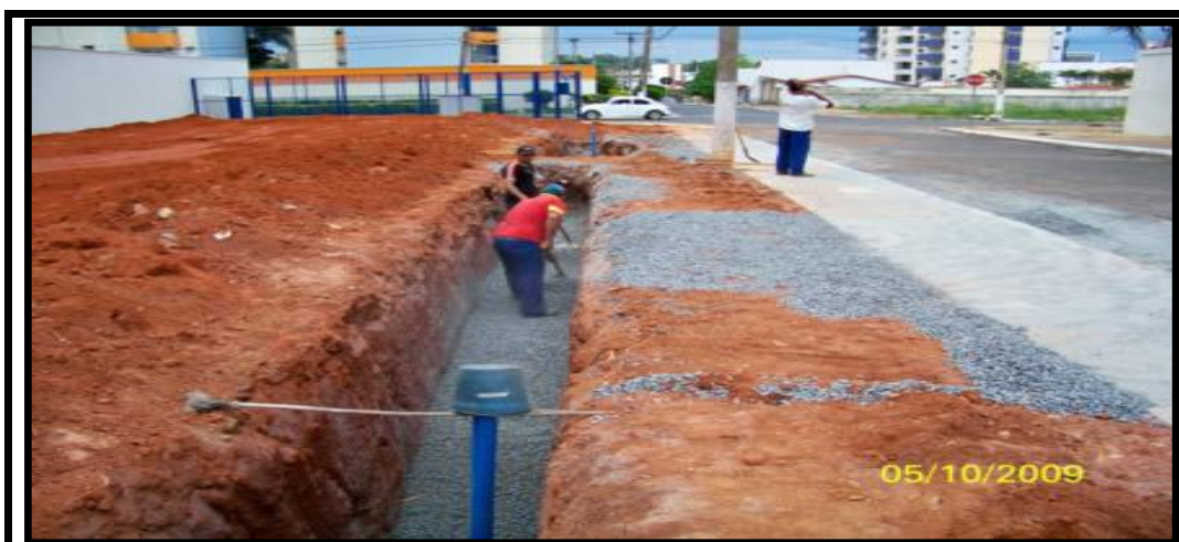
Figura 33: Foto mostrando a construção das valas no Setor Turista I. Em primeiro plano veem-se os piezômetros para monitoramento do experimento. Foto: AMAT (2009)
