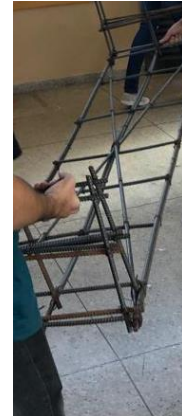
Figura 26 Estrutura em aço para o banco de concreto
