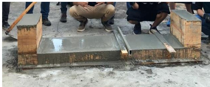
Figura 30 - Banco de concreto em processo de cura
