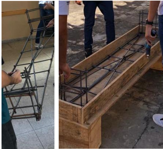
Figura 29 - Armação construída em aço 10 mm
