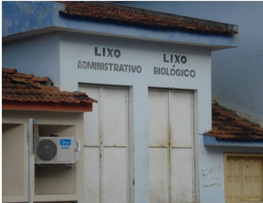
Fotografia 4 – Depósito dos resíduos de saúde da Fundação Hospitalar Senhora Santana de Caetité, Bahia.
