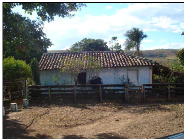
Foto 23 - Residência com paredes de adobe: comunidade Paulistas, Catalão (GO) - 2010. Fonte: Pesquisa de campo. Acervo NEPSA.
