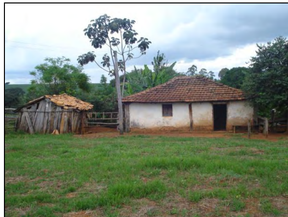
Foto 21 - Residência com paredes de adobe e piso batido: comunidade Cruzeiro dos Martírios, Catalão (GO) - 2008. Fonte: Pesquisa de campo. Autora: Martins Silva.
