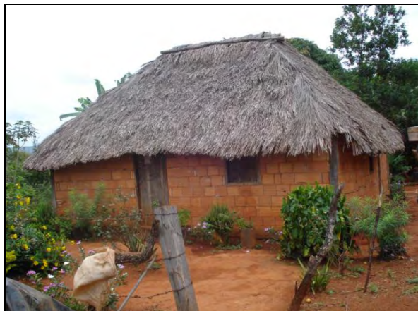
Foto 20 - Residência com paredes de alvenaria e cobertura de palha e piso batido: comunidade Cruzeiro dos Martírios, Catalão (GO) - 2008. Fonte: Pesquisa de campo. Autor: Martins Silva.
