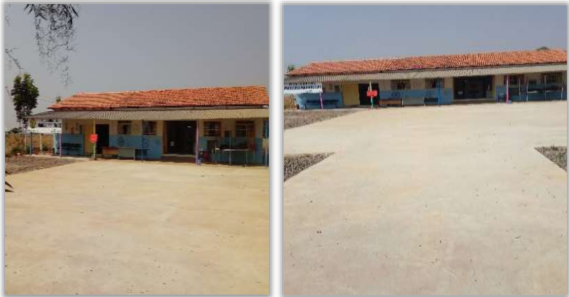
Fotos 29 e 30 – Escola da Roça reformada.
