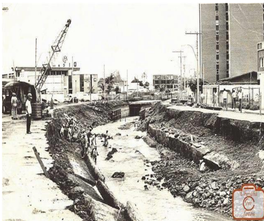
Foto 3 - Obras de canalização do Córrego das Lajes, em Uberaba (MG), na década de 1960
