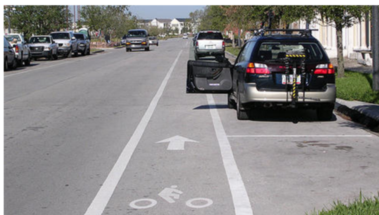
Figura 8 – Exemplo de ciclovias onde a porta invade o espaço do ciclista - Fonte: adaptado pelo autor
