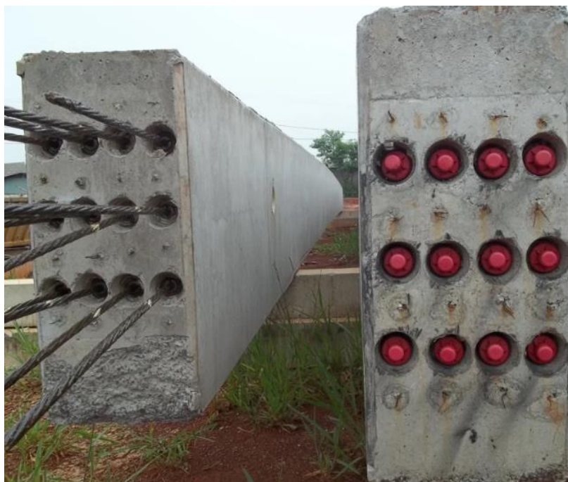
Figura 8 – Viga Protendida Pré-Moldada
