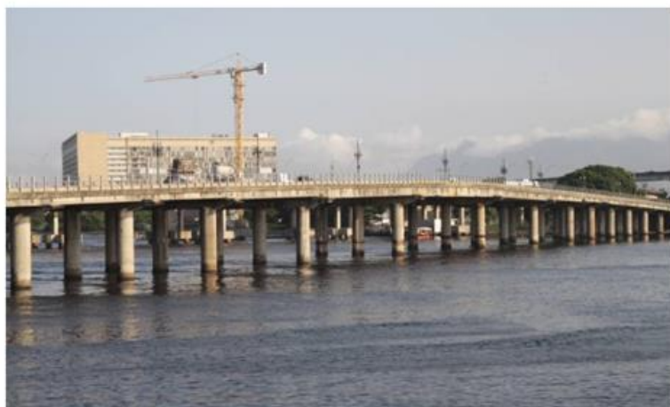
Figura 3 – Ponte do Galeão
