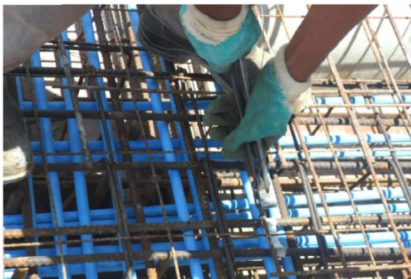
Figura 11 – (A) Laje Nervurada Protendida, (B) Detalhe das cordoalhas engraxadas (C) Processo de Concretagem da Laje
