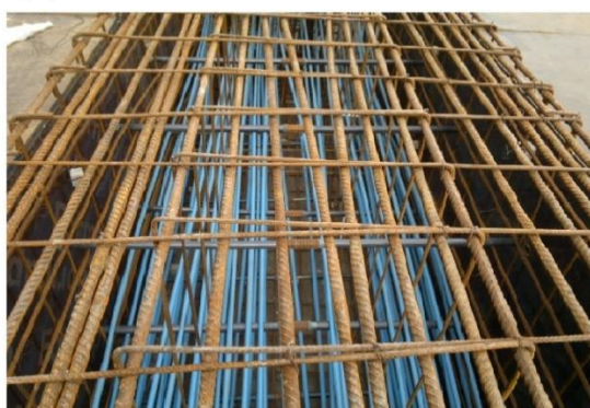
Figura 12 – (A) Viga Protendida, (B) Vista Lateral da Viga, (C) Detalhe das Cordoalhas Engraxadas
