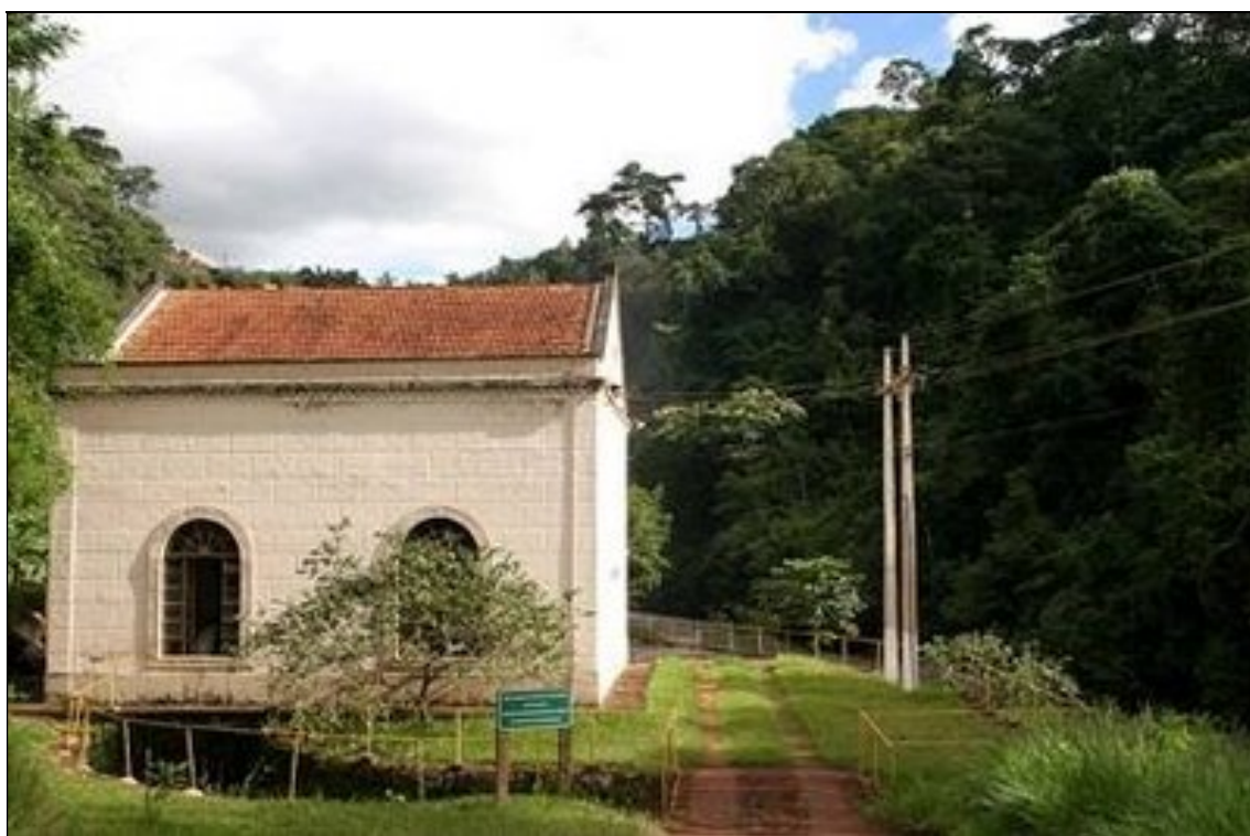
Figura 25: Casa de máquinas da usina Piçarrão.
