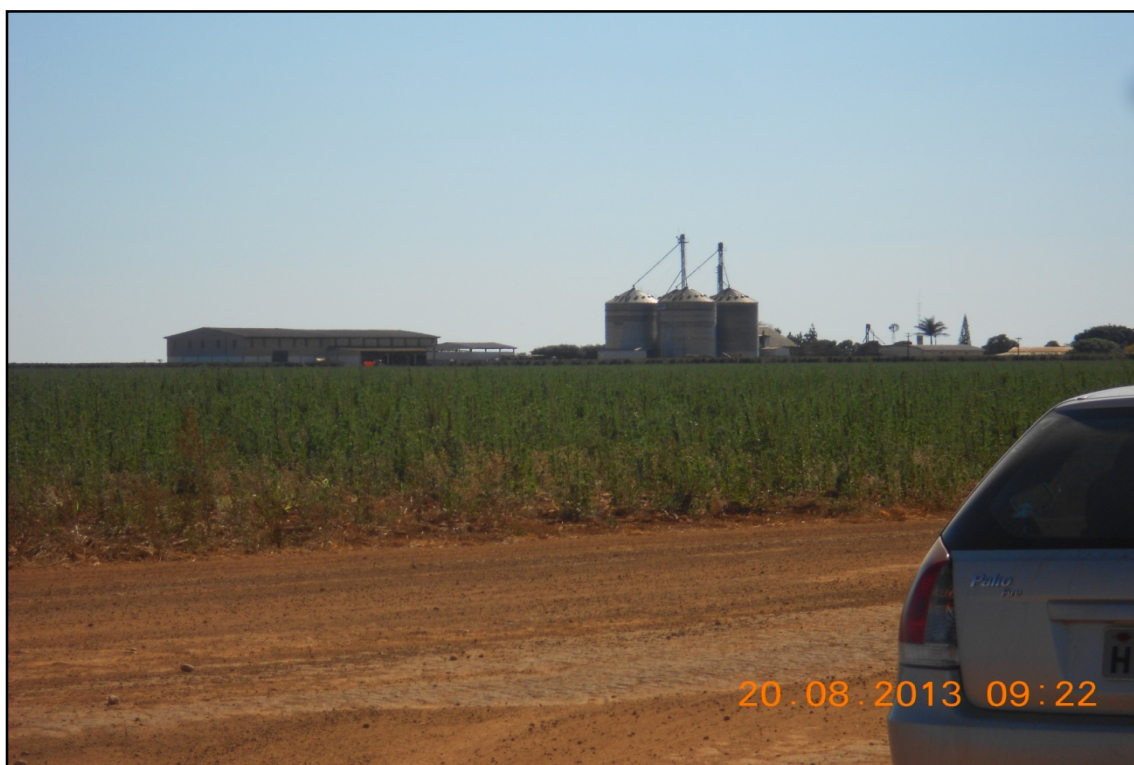
Figura 14: Estrutura do Agrobusiness na bacia do rio Jordão em Araguari (MG) é composta por Silos para armazenagem de grãos, como também indústrias para o processamento da produção da área de estudo e também da região do entorno da mesma.
