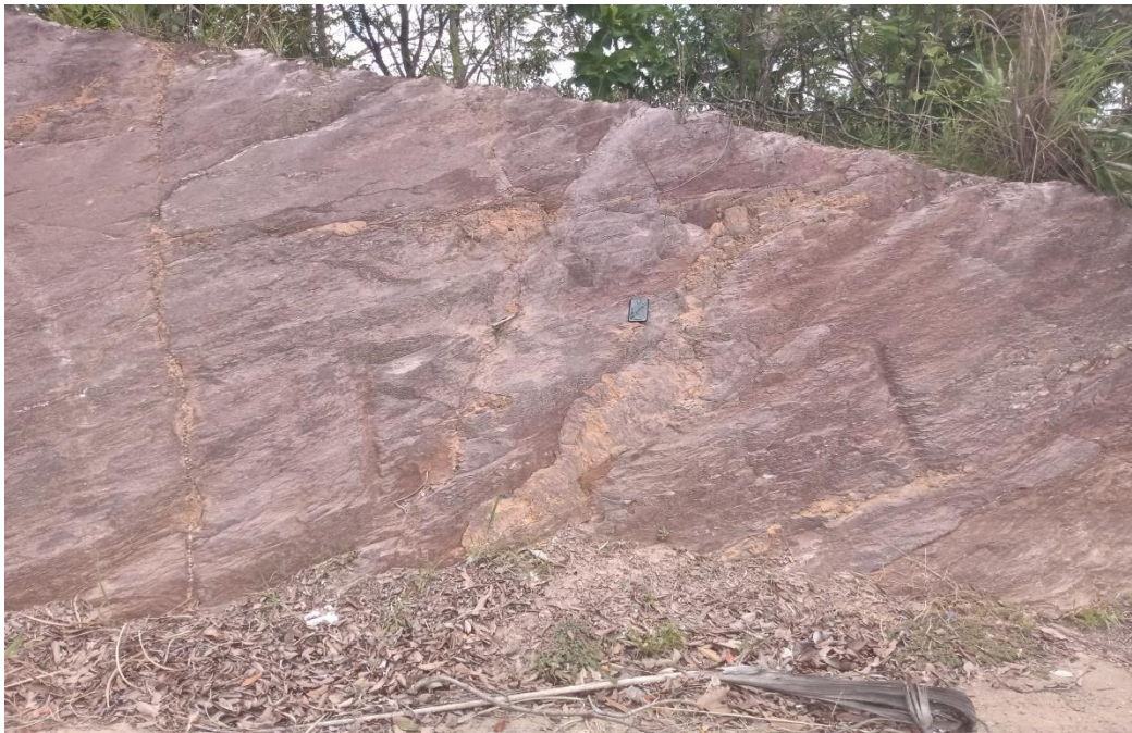
FIGURA 05 – Micaxisto , fraturado intemperizado no alto do CAQ, trecho urbano bairro Esplanada Rio Quente -GO
