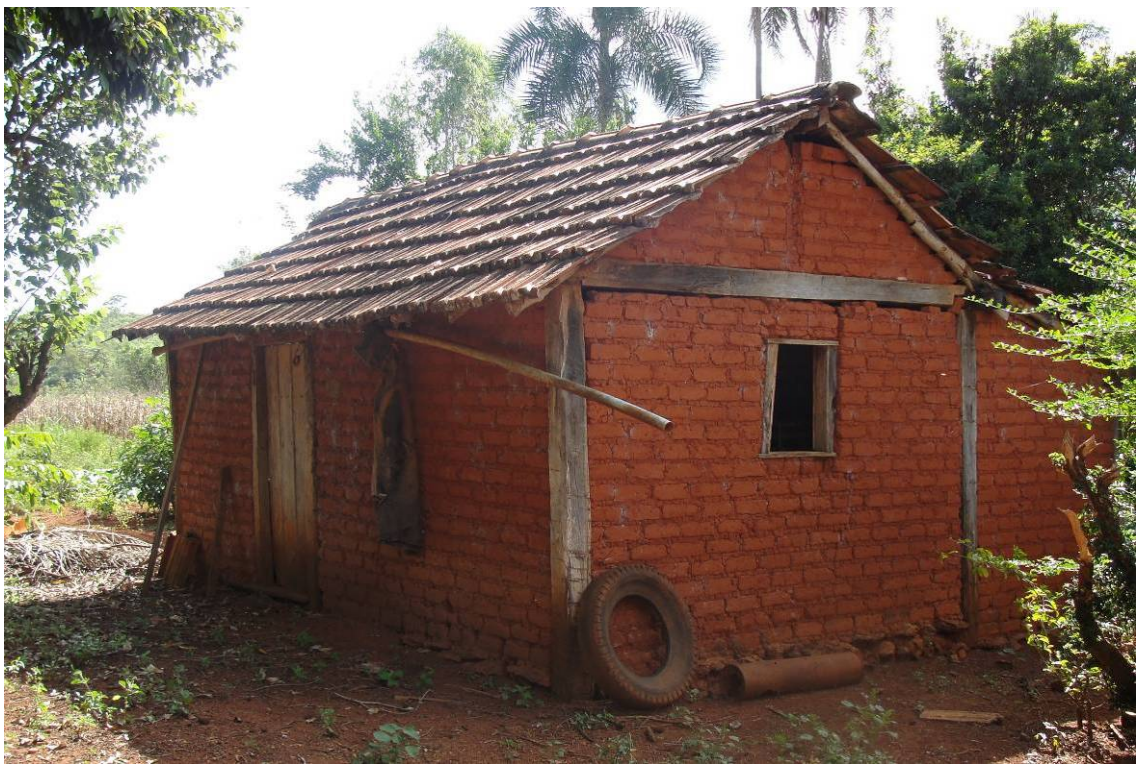
Foto 10 - Residência de adobe na propriedade de Alcides J. da S., comunidade rural de Rancharia, Campo Alegre de Goiás (GO). Autora: Dartora, V. ago./2010. Fonte: Trabalho de Campo.
