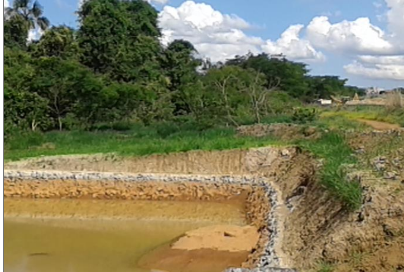
Foto 25: Lagoa de contenção de resíduos na área da APP na BHRS, Catalão (GO)
