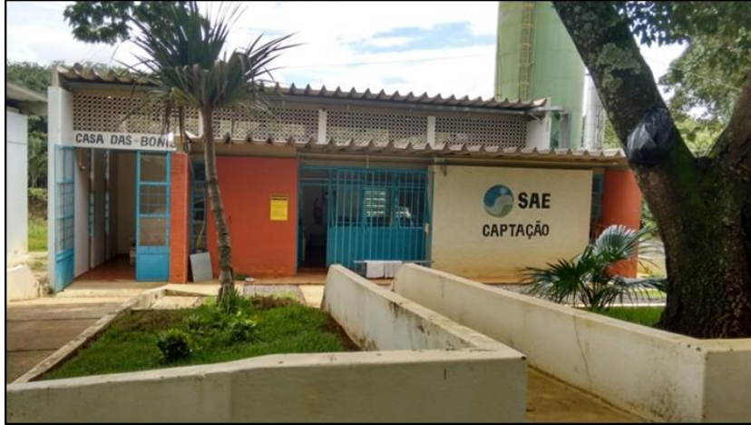
Foto 1: Captação de água para abastecimento público da cidade de Catalão (GO), SAE
