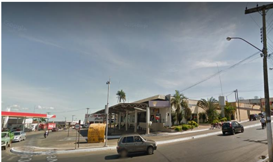
Figura 11: Vista da Subestação Rodoviária do Bairro São João, Catalão – GO.
