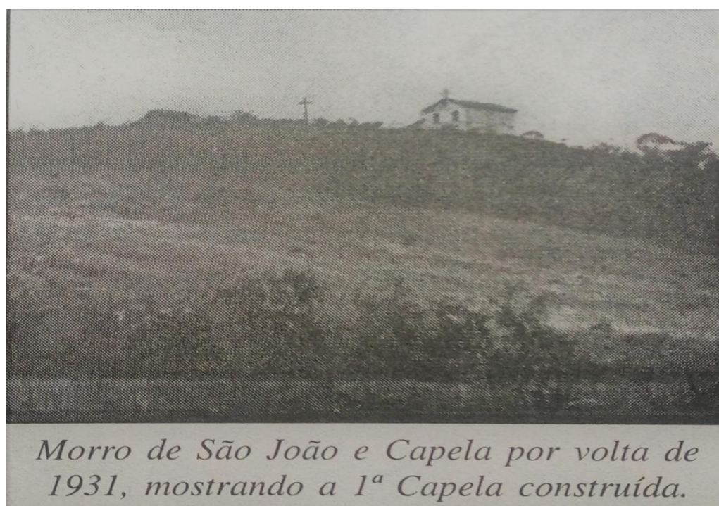
Figura 15: Primeira Capela de São João Batista no Bairro São João, Catalão – GO.
