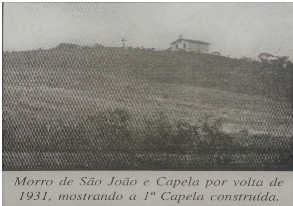
Figura 6: Primeira Capela de São João Batista no Bairro São João, Catalão – GO.
