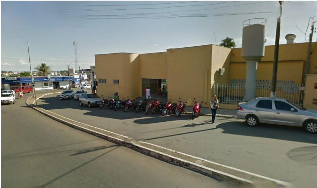
Figura 12 - Vista da Subestação Rodoviária do Bairro São João, Catalão – GO sem vegetação.
