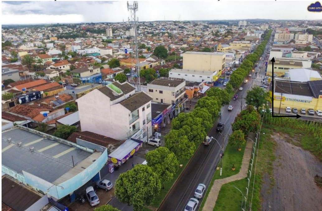
Figura 14: Trecho da Avenida Dr. Lamartine Pinto de Avelar, Catalão - GO (com vista a partir do Supermercado Mercadão da Economia em direção ao São João).
