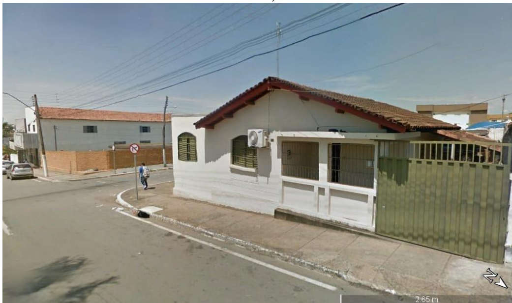
Figura 17: Casa antiga no cruzamento da Av. São João com Rua Minas Gerais no Bairro São João, Catalão - GO
