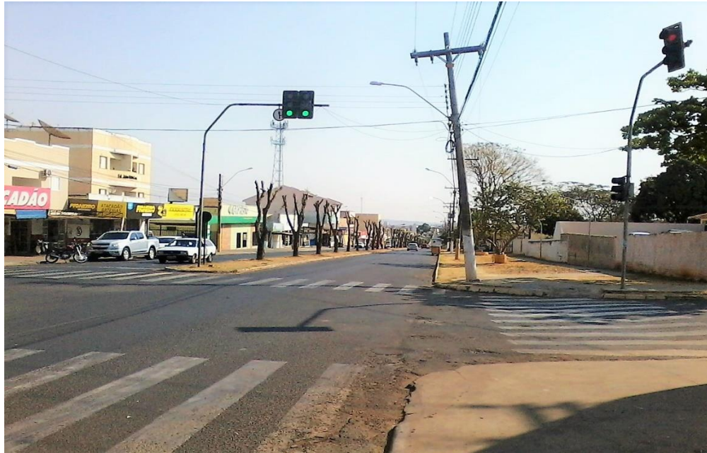
Figura: 23: Poda das árvores do canteiro central da Av. Lamartine, Catalão - GO
