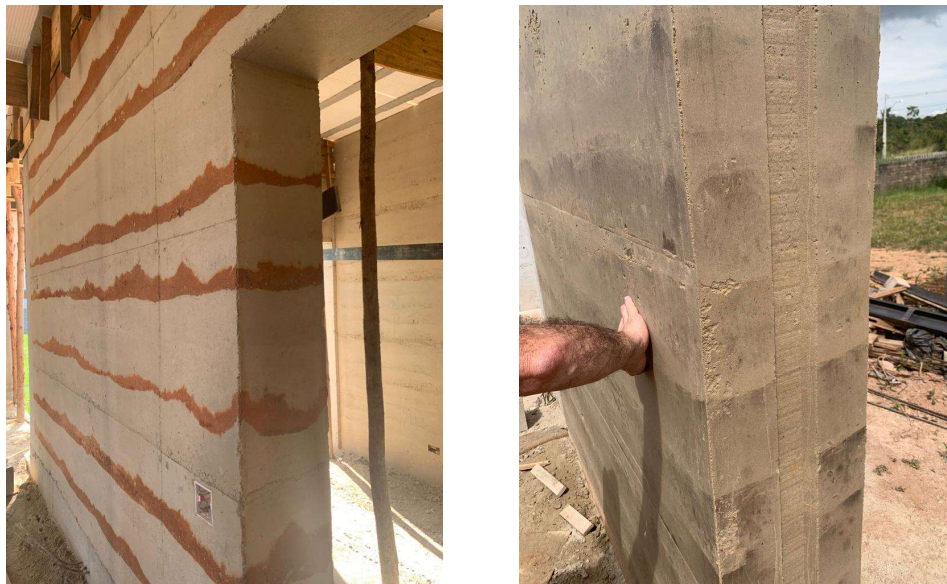
Figura 10 - Parede taipa de pilão estudo de Caso
