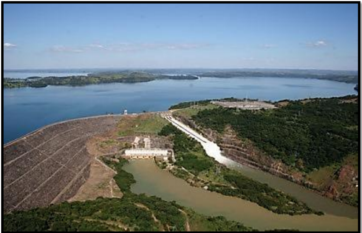
Foto 7 – Imagem aérea da barragem da UHE Emborcação (2007).
