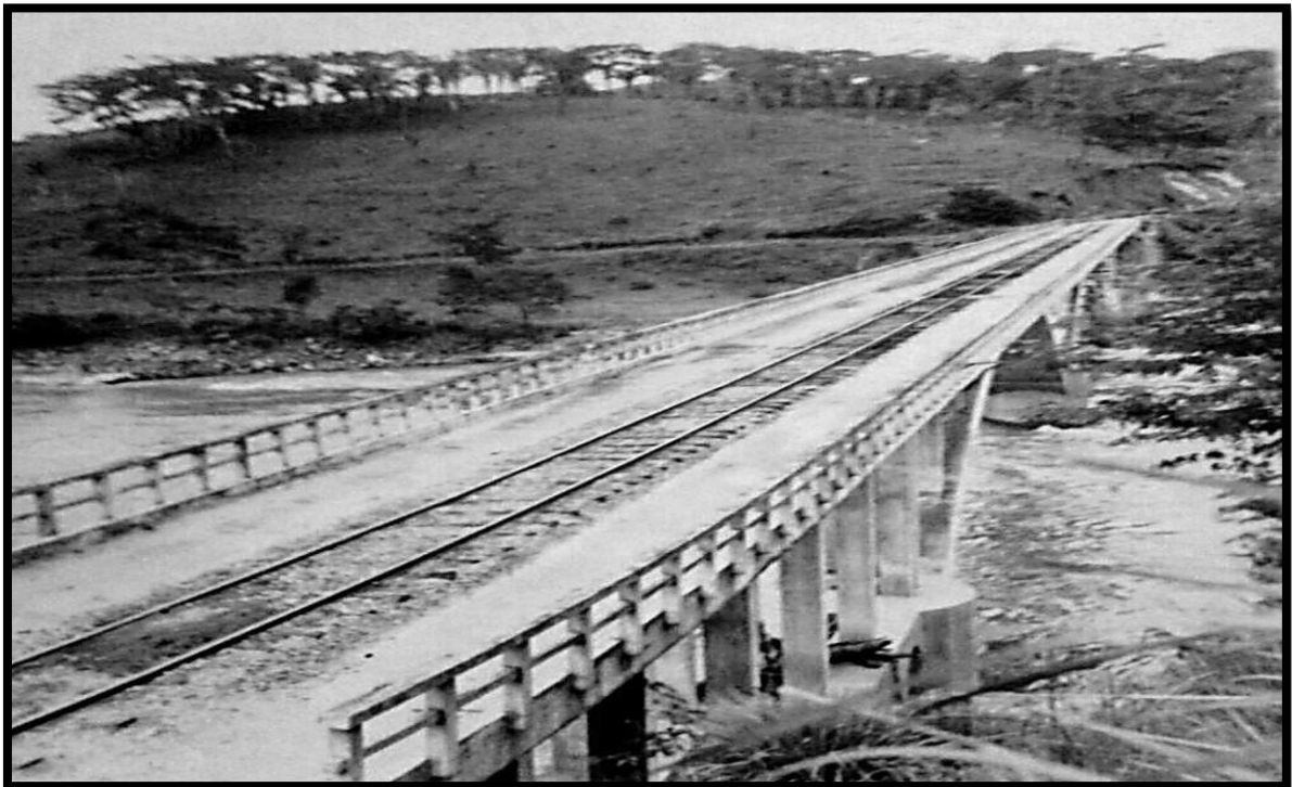
Foto 4 - Ponte Férrea de Três Ranchos (1957).
