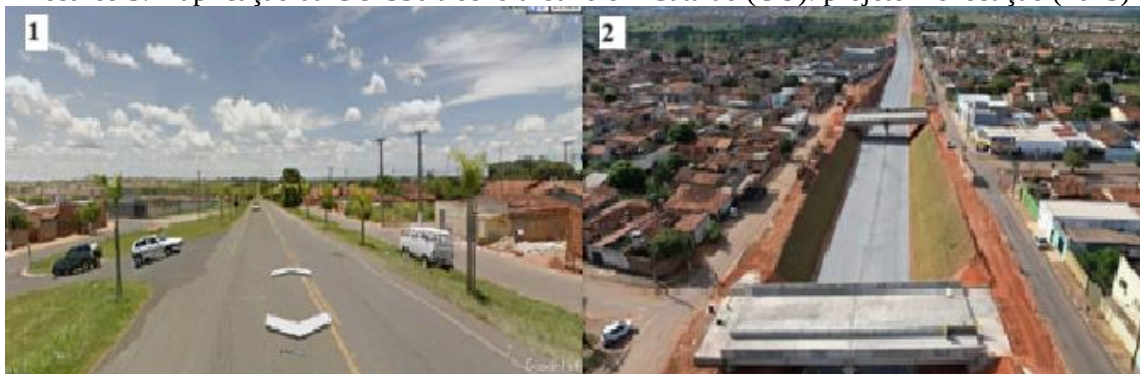
Mosaico 5: Duplicação da GO-330 trecho urbano em Catalão (GO): projeto x execução (2023)
