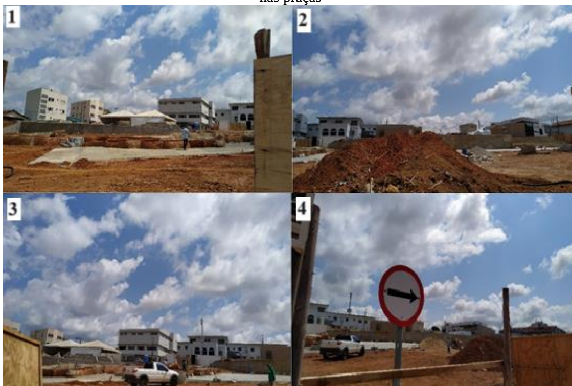
Mosaico 26: Demolição da Praça das Mães em Catalão (GO) ponto inicial da operação urbana nas praças
