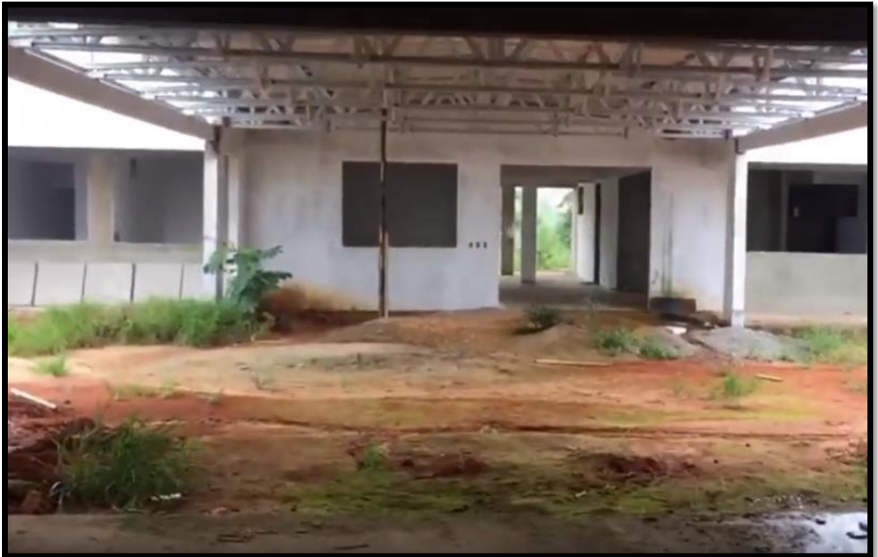
Foto 03: Vista da Creche padrão PNDE do Bairro Jardim Europa – obra inacabada
