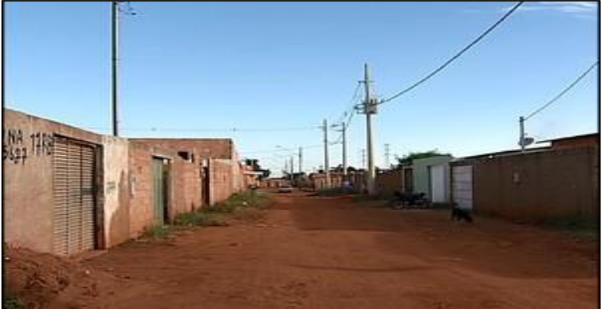
Figura 12 – Rua do Jardim Prosperidade, Uberlândia (MG).
