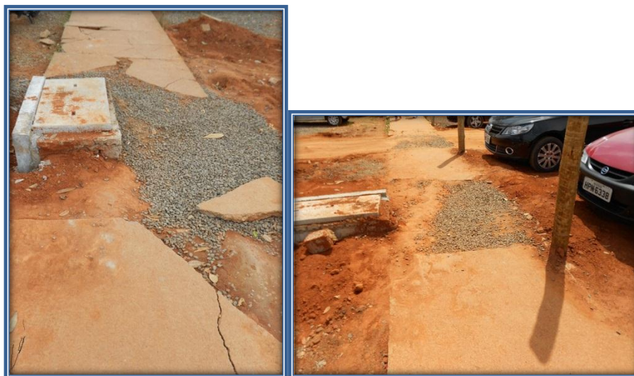
Fotografias 1 e 2 - Rota 1: área de circulação externa
