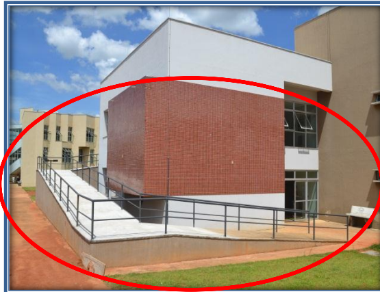
Fotografia 8 – Visão geral do Bloco de Laboratórios (entrada principal e rampa)
