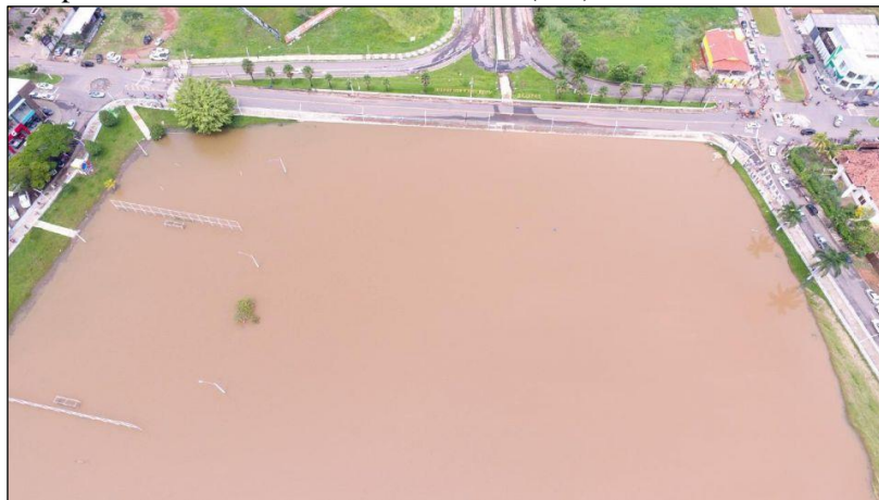
Figura 11: Represa do Clube do Povo em Catalão (GO) no seu limite de armazenamento.
