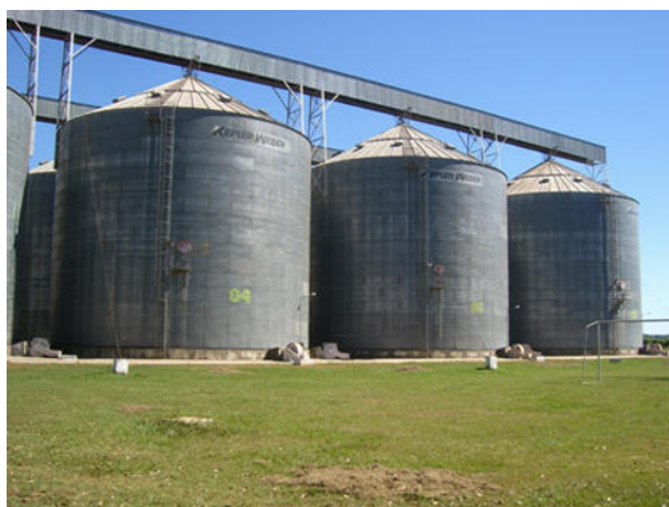
Figura 1 – Silo de metal.
