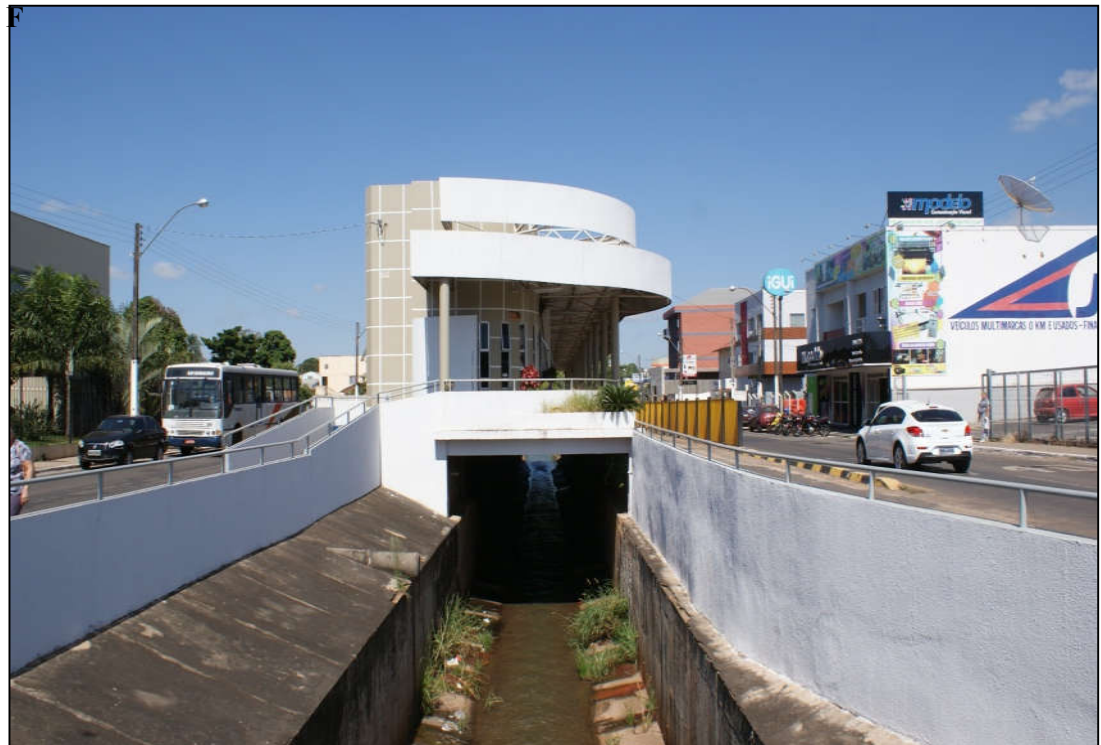
Foto 10 - Catalão (GO): vista parcial do Terminal, sobre o Ribeirão Pirapitinga –2013.
