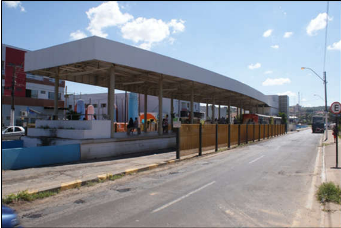
Foto 9 - Catalão (GO): vista parcial do terminal de coletivos, sentido Leste-Oeste – 2013.
