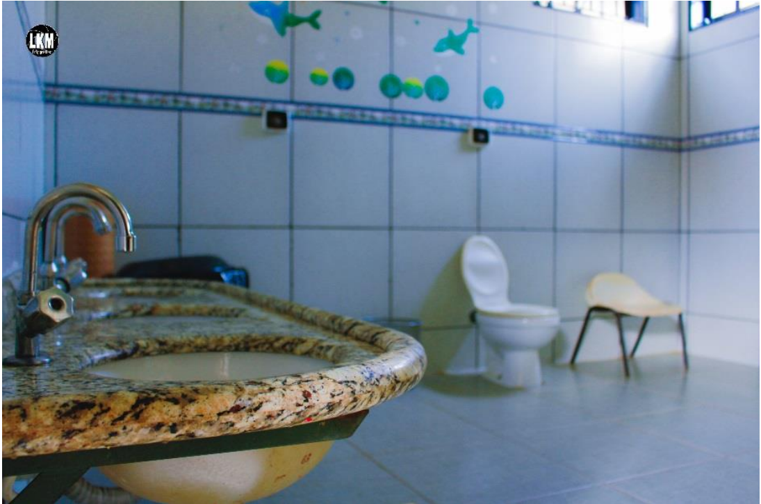
Figura 18 – Banheiro infantil do CEMEI Ana Ramos dos Santos
