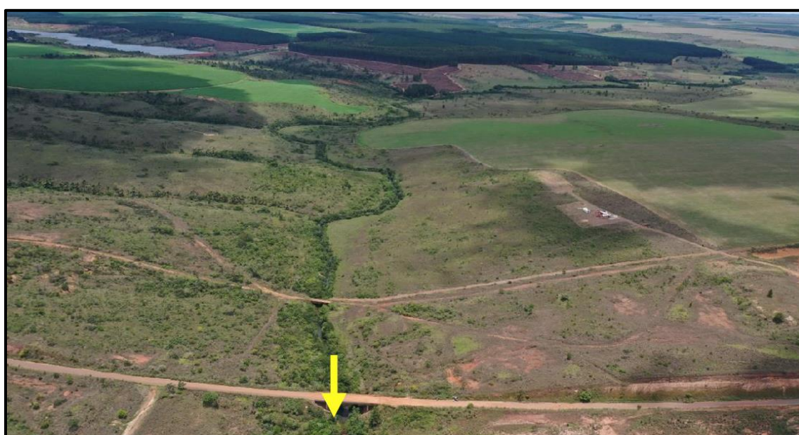
Figura 11 - Ponte sobre o Rio São Bento Montante – Ponto de Coleta 5, Catalão (GO)
