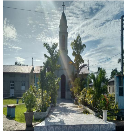
Foto 10: Prédio da Igreja São Francisco de Assis - 2016.
