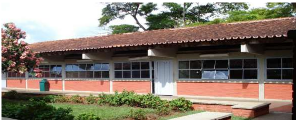
Figura 11 – Estrutura de uma das fachadas laterais interna da escola. Fonte: RESENDE 2013 p.109, a partir da consulta ao repositório
