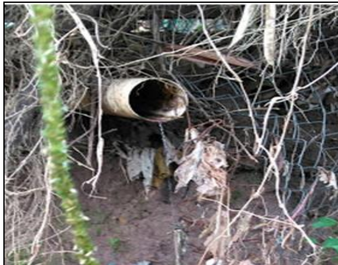
Figura 34: Lançamento de efluentes no Córrego Lagoinha
