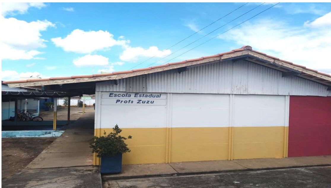
Foto 3: Vista Parcial da Escola Estadual “Professora Zuzu”
