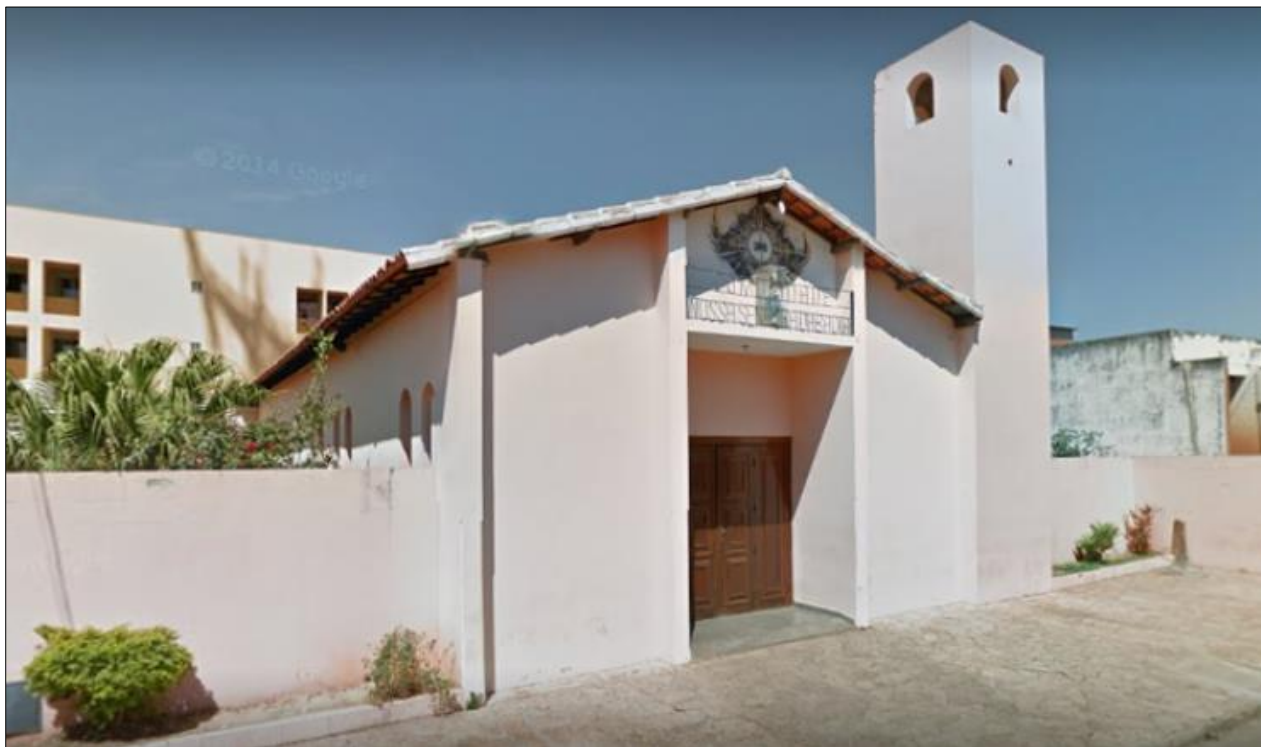
Figura 28 – Registro da atual Igreja de Nossa Senhora da Abadia.
