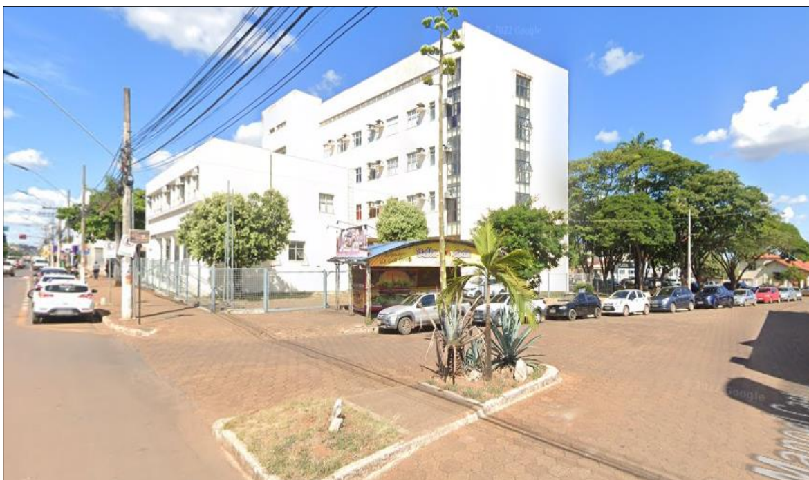
Figura 26 - Imagem atual do prédio do Fórum de Justiça de Paracatu e o antigo Largo da Abadia (Praça Afrânio de Melo Franco), local onde se encontrava a suprimida Igreja da Abadia.
