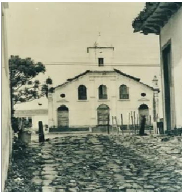
Figura 29 - Igreja de Nossa Senhora do Rosário, após reforma em 1922.
