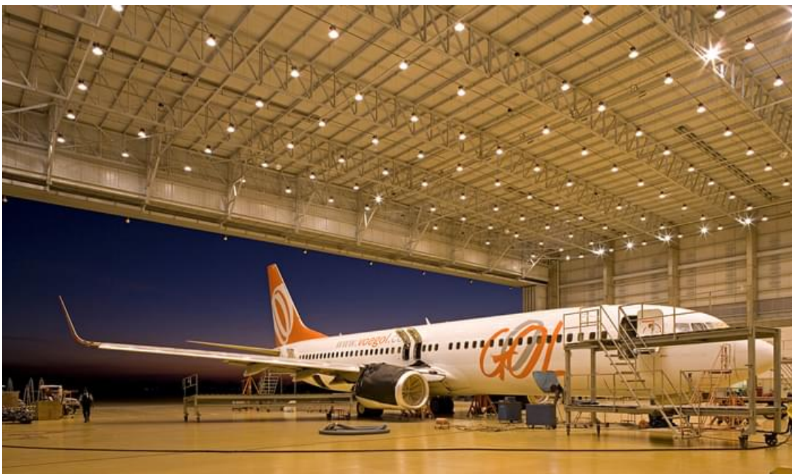
Figura 1.2 – Centro de manutenção da Gol
