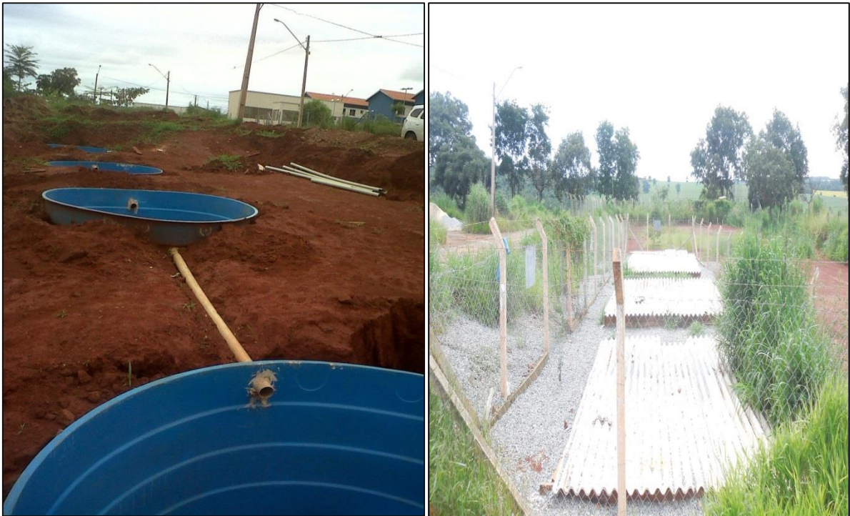
Foto 2: Construção de sistema de fossas coletoras 2015 (à esquerda) e sistema consolidado em 2016 (à direita) no conjunto Maria Amélia I e II em Catalão (GO)
