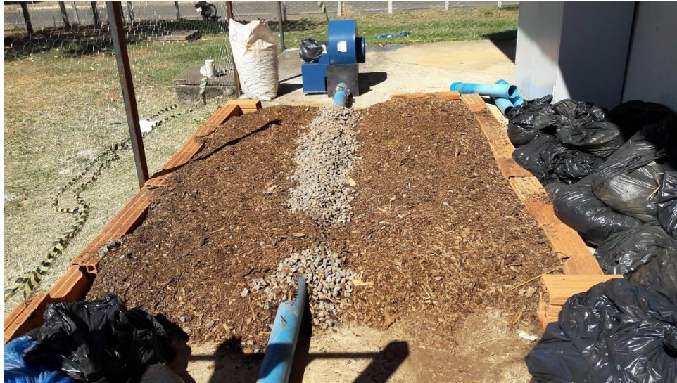
Figura 28 - Cobertura do tubo de PVC.
