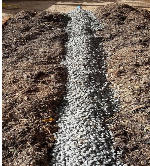
Figura 12 - Cobertura do tubo com brita.
