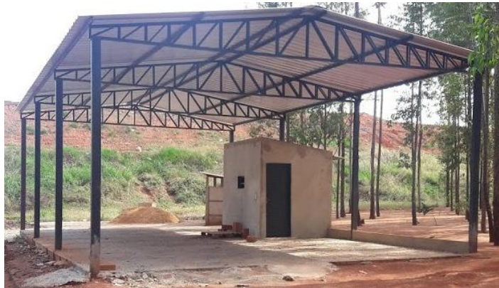
Figura 21 - Galpão para montagem das leiras.
