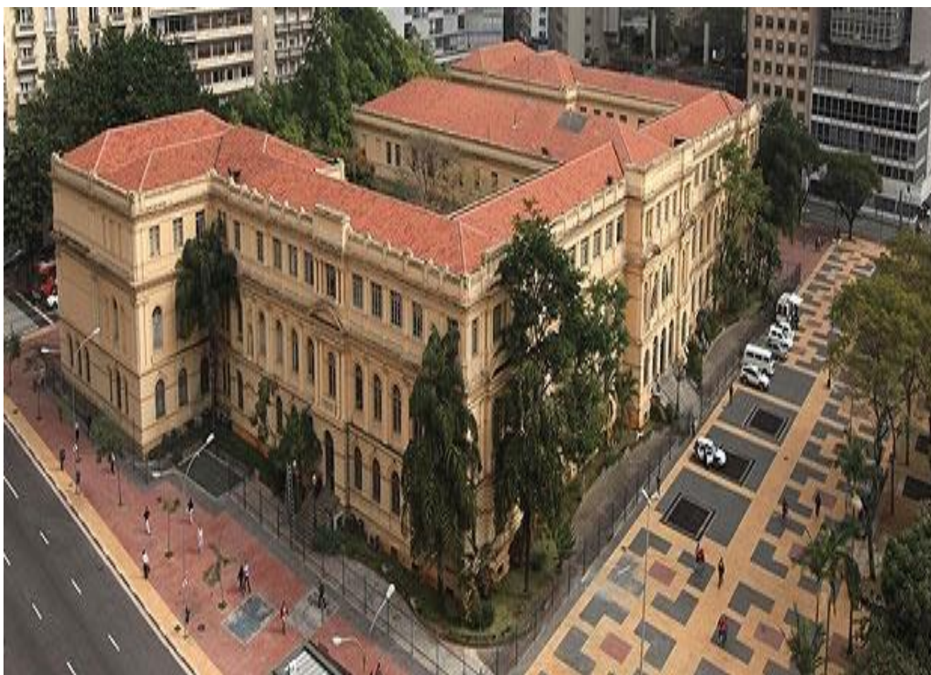
Foto 2: O terceiro andar Escola Normal Caetano Campos foi construído em 1930.
