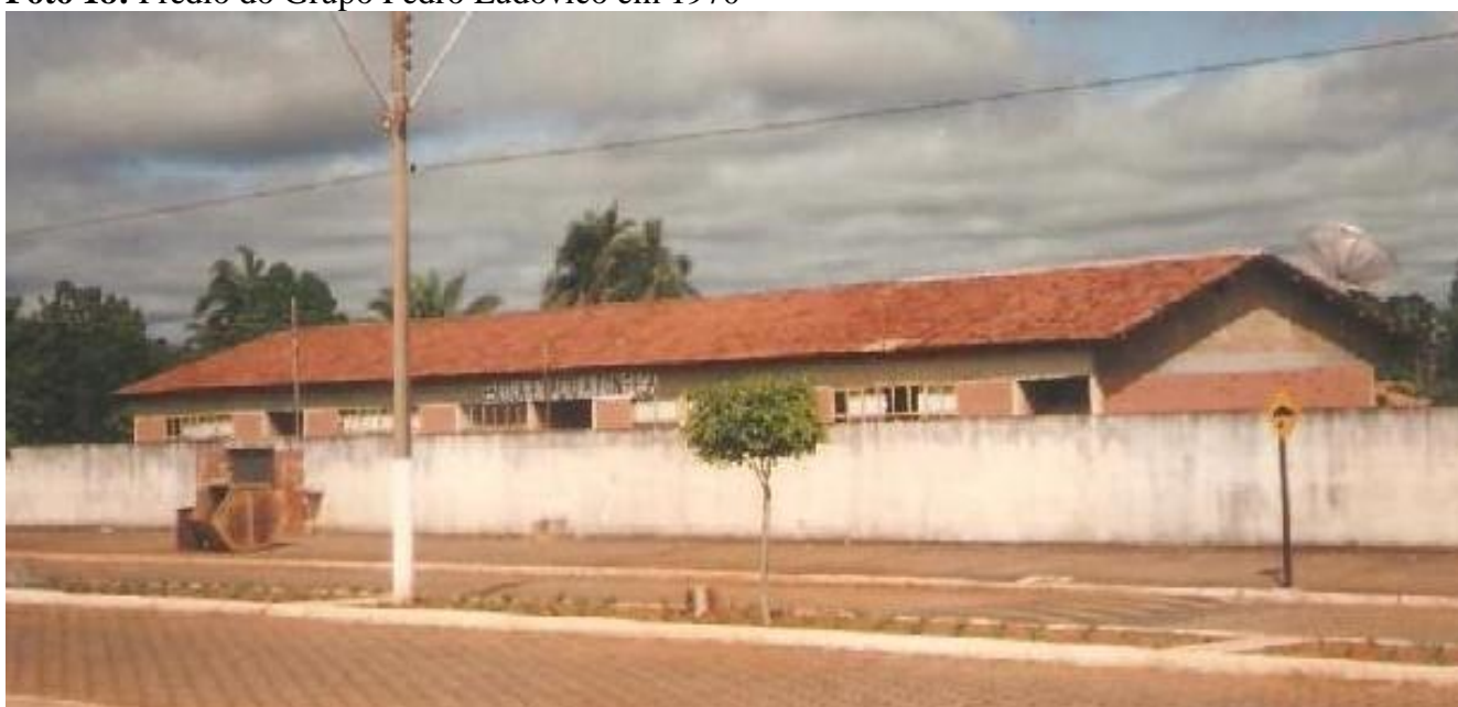
Foto 18: Prédio do Grupo Pedro Ludovico em 1970
