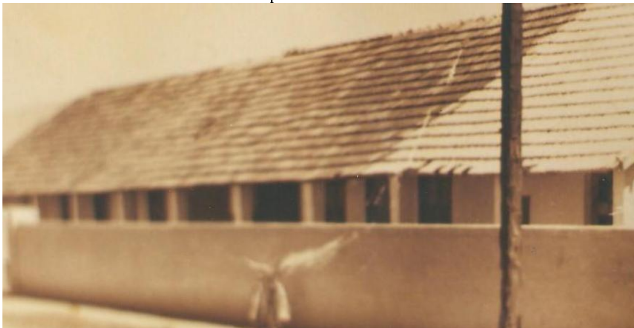
Foto 17: Detalhe do telhado de Grupo Escolar de Ouvidor em 1950.
