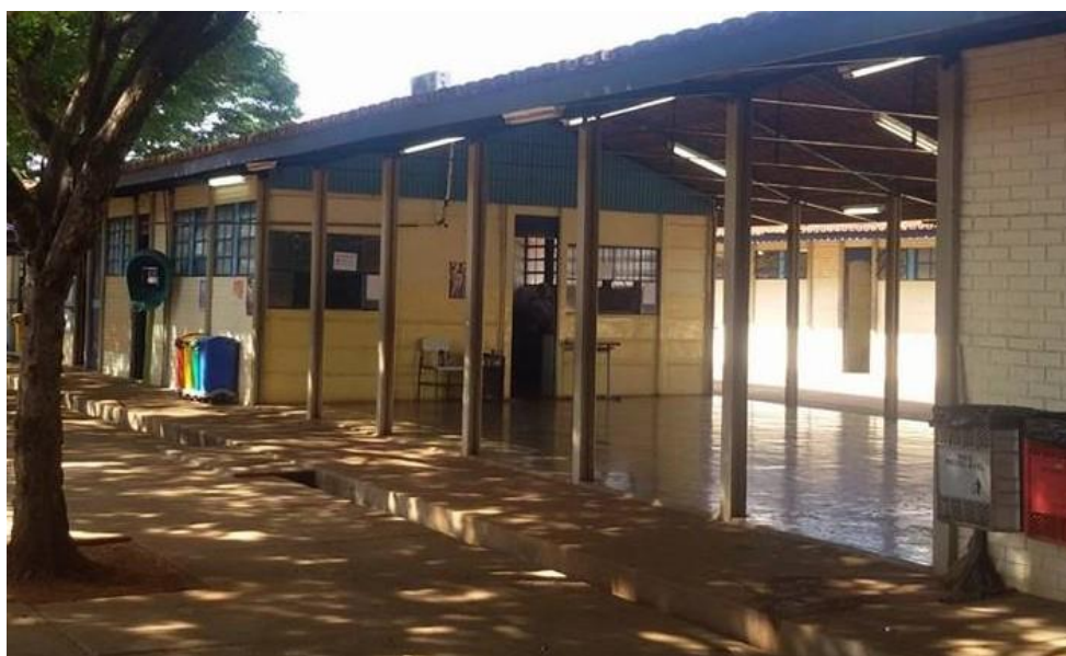
Foto 1 - Colégio Estadual Maria das Dores Campos edificada com placas de cimento. Org.: VALE, Suzana Alves. 2015.
