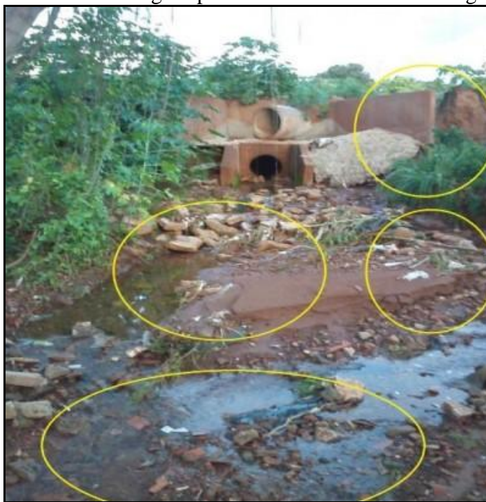
Figura 45 - Galerias de águas pluviais na cabeceira do Córrego Buritizal
