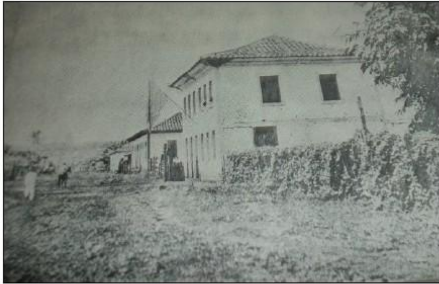
Figura 34 - Ituiutaba (MG): construção do edifício da Câmara Municipal, 1901
