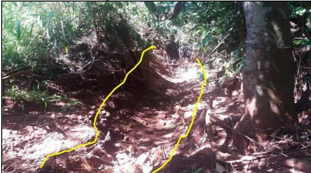
Figura 27 - Erosão em ravinas
