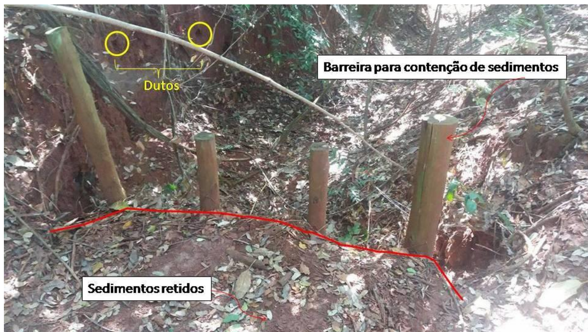
Figura 61 - Sistema de barramento aplicado no interior do Parque do Goiabal
