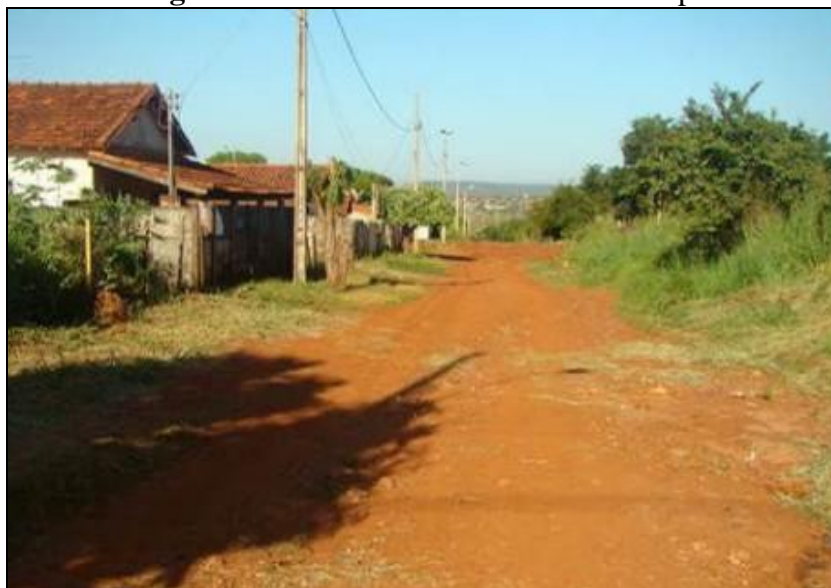
Figura 43 - Rua sem asfalto no Bairro Tupã
