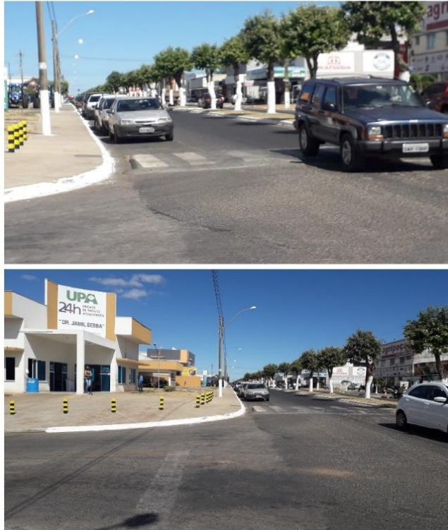
Foto 8 – Fixa elevada em frente a UPA na Avenida Dr. Lamartine Pinto de Avelar em Catalão (GO).
